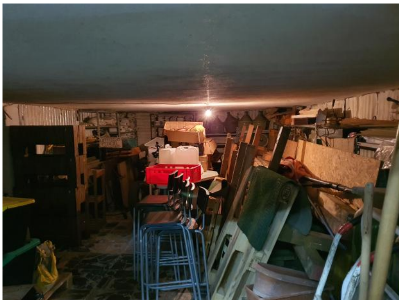
VISTA INTERNO SUB 6
