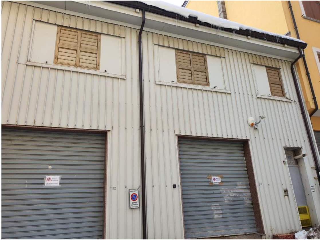
VISTA IN PROSPETTO LOCALE SUB 9
