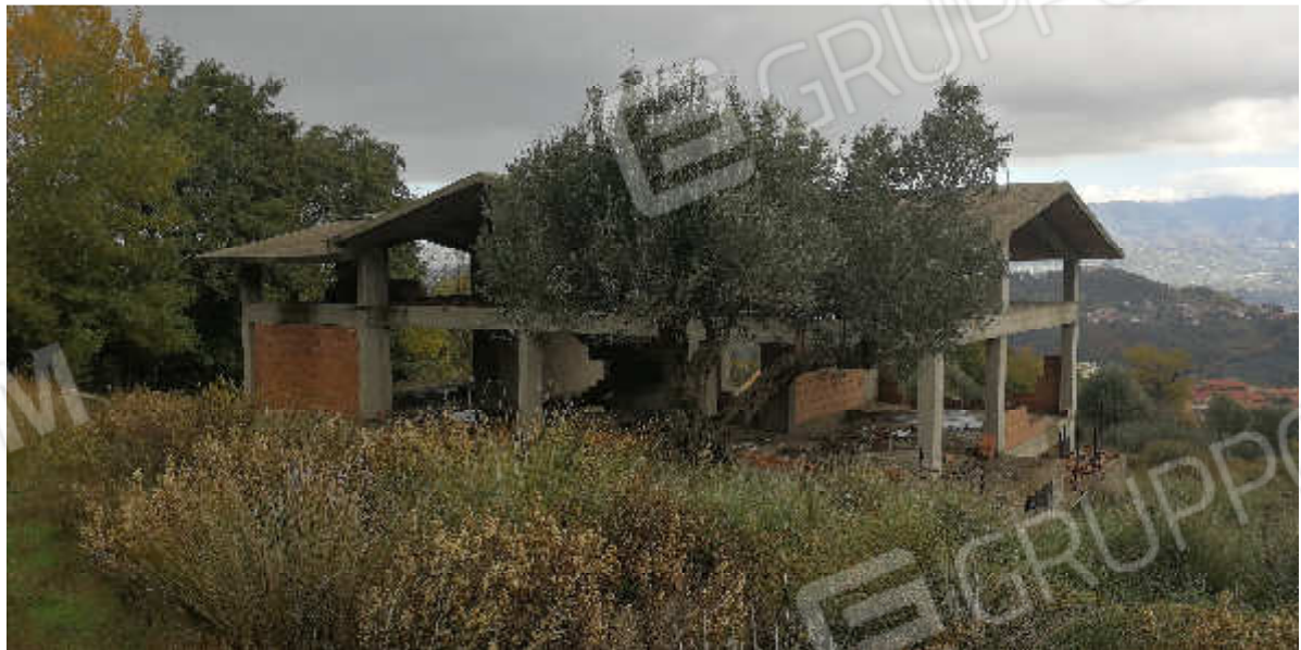
FOTO N. 03 – ESTERNO FABBRICATO IN CORSO DI COSTRUZIONE
