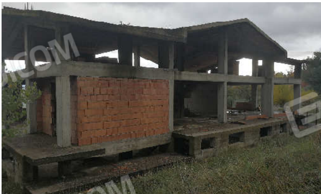
FOTO N. 04 – ESTERNO FABBRICATO IN CORSO DI COSTRUZIONE
