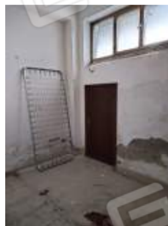
Foto n. 5 – Particolare porta murata
