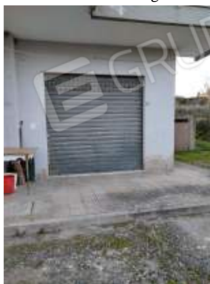
Foto n. 11 – Uscita esterna magazzino
