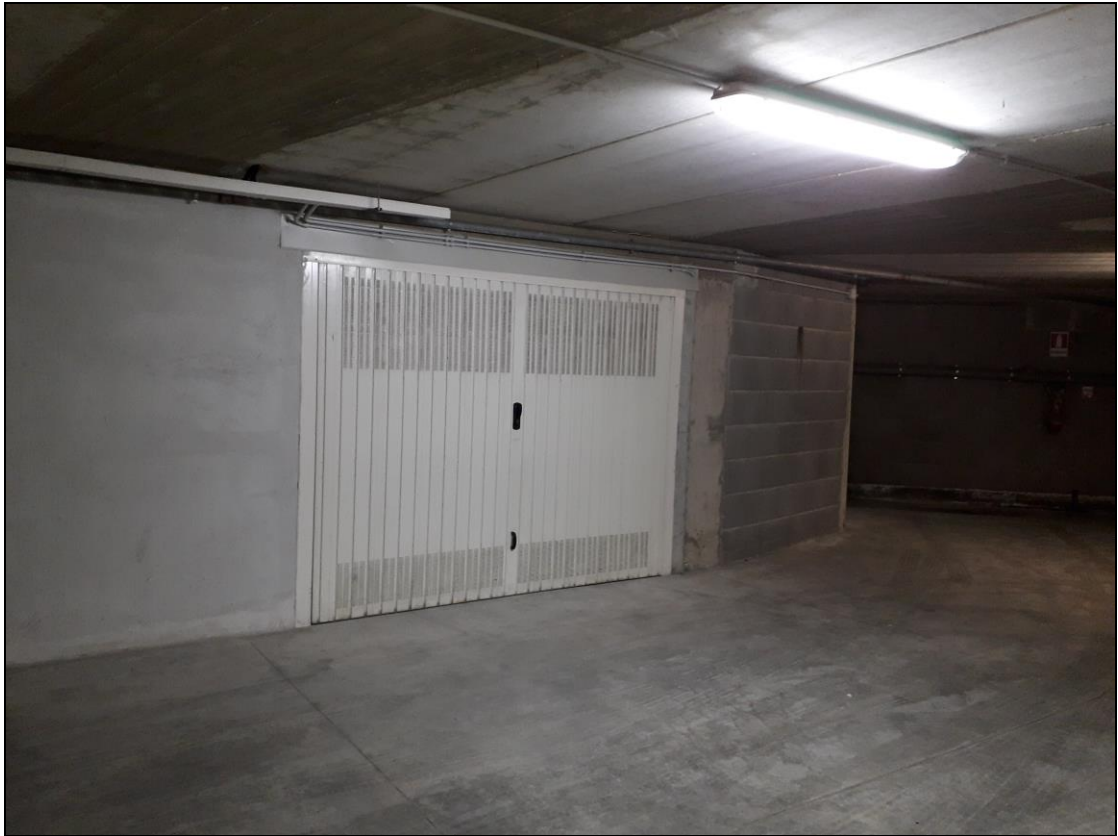
Foto n. 1: Ingresso box auto
