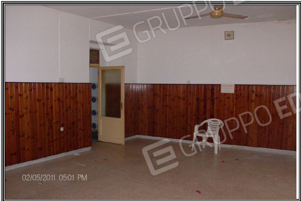
FOTOGRAFIA n. 3 – Vista dall'interno "Locale Commerciale"
