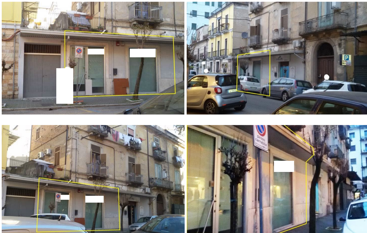
Immagine n.4 – in evidenza i prospetti delle unità immobiliari pignorate su via Sabotino
