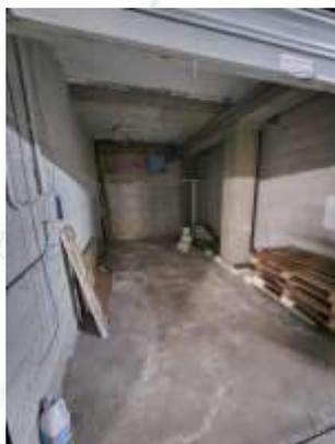
L'immobile, aperto con l'ausilio di un fabbro, è adibito a magazzino deposito, con partizioni in blocchi di cemento e saracinesca in lamiera ondulata.
