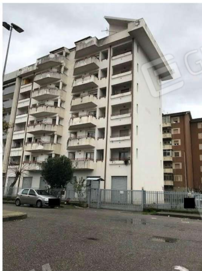
Prospetto- via G. D'Amico n. 18 - Foto n. 2
