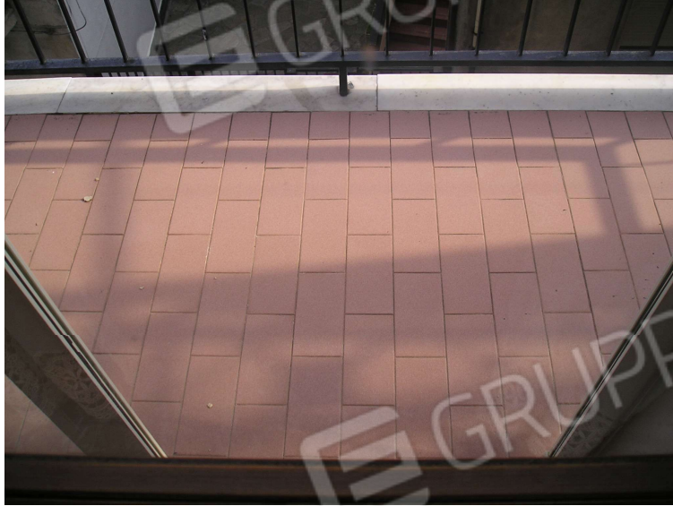
Foto n. 18: particolare balcone - immobile 2
