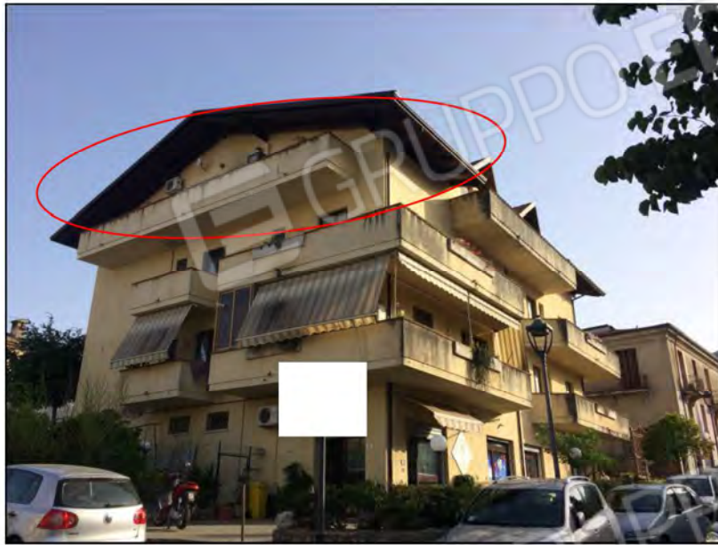
Foto n. 15: Esterno dell'immobile Prospetto Lato Strada
