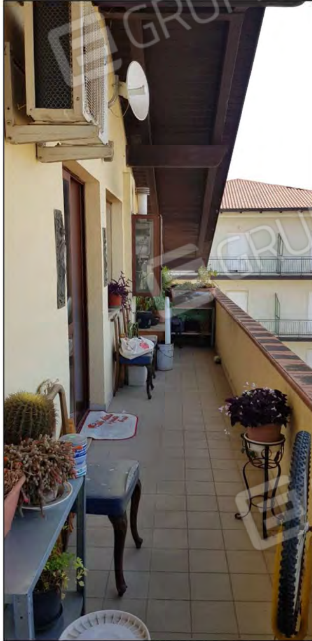
Foto n. 17: Esterno dell'immobile Balcone Zona Giorno
