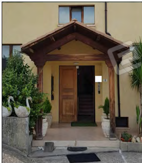
Foto n. 2: Esterno dell'immobile Ingresso
