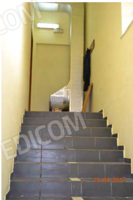
Foto n. 18: Scale piano rialzato - piano seminterrato
