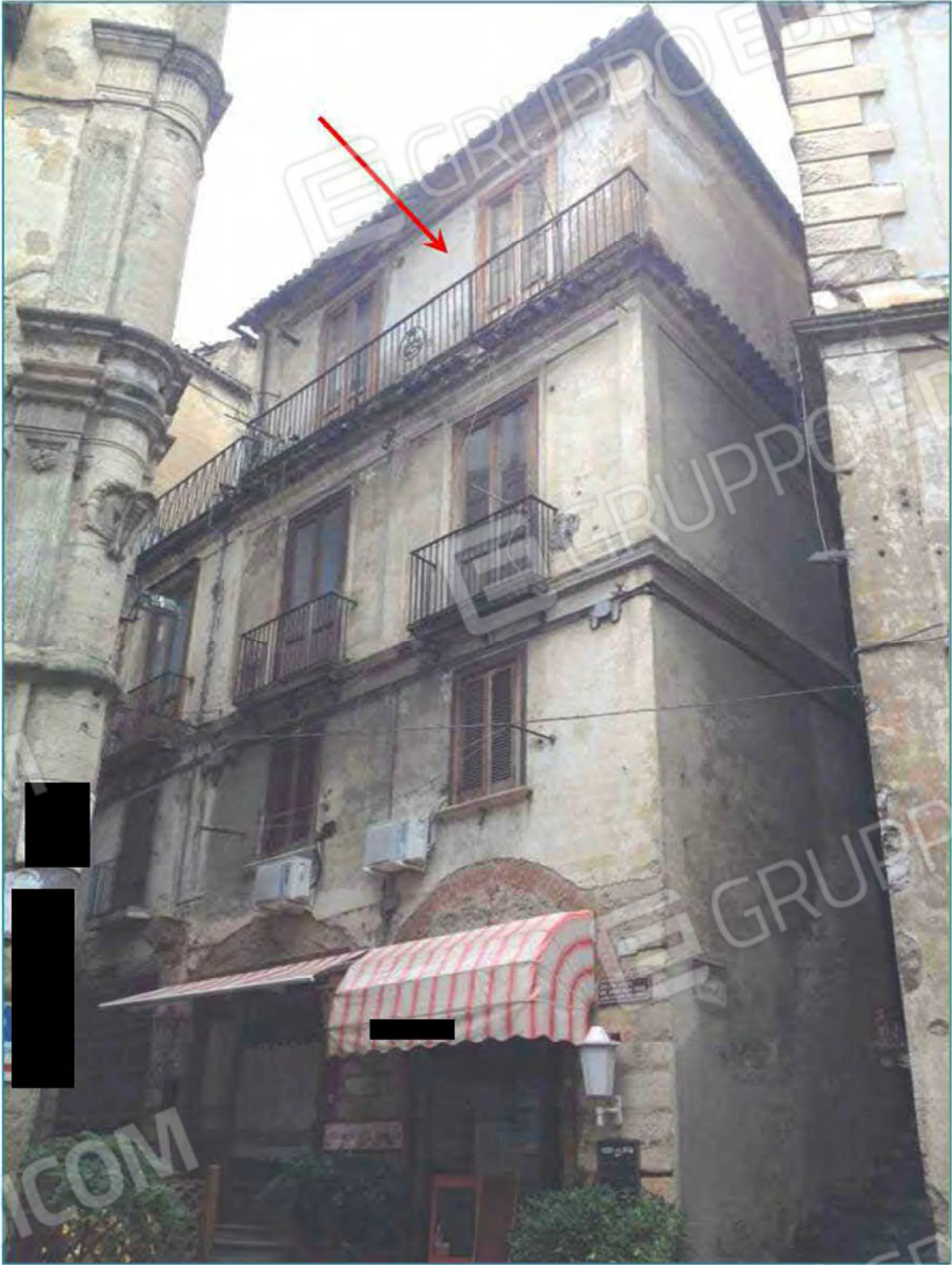
Foto n. 4 (Vista da Corso Telesio)
