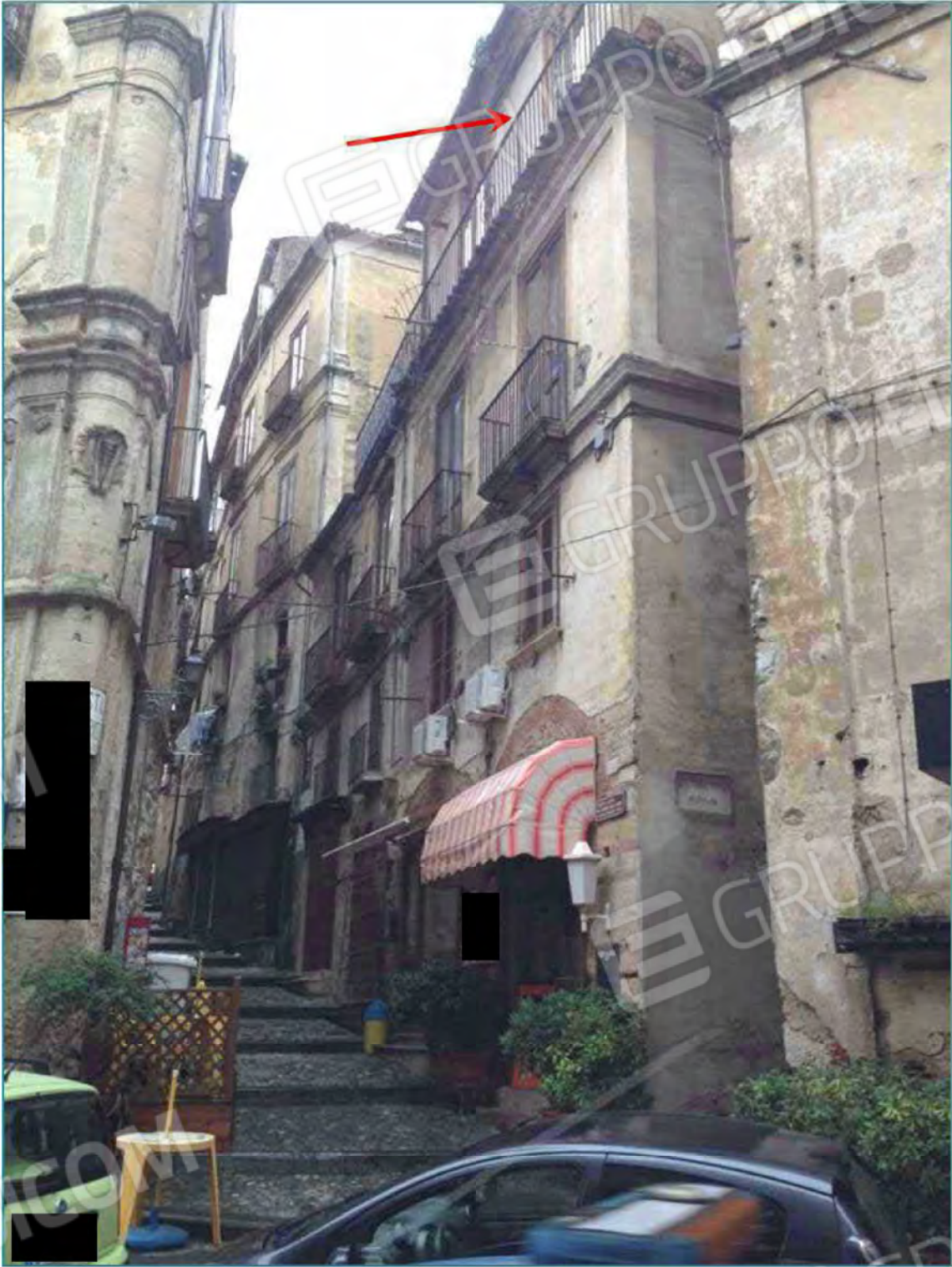
Foto n. 5 (Vista da Corso Telesio)
