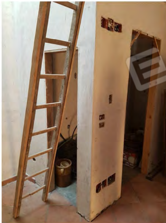
Figura 4 – Particolare scale e ingresso bagno piano terra
