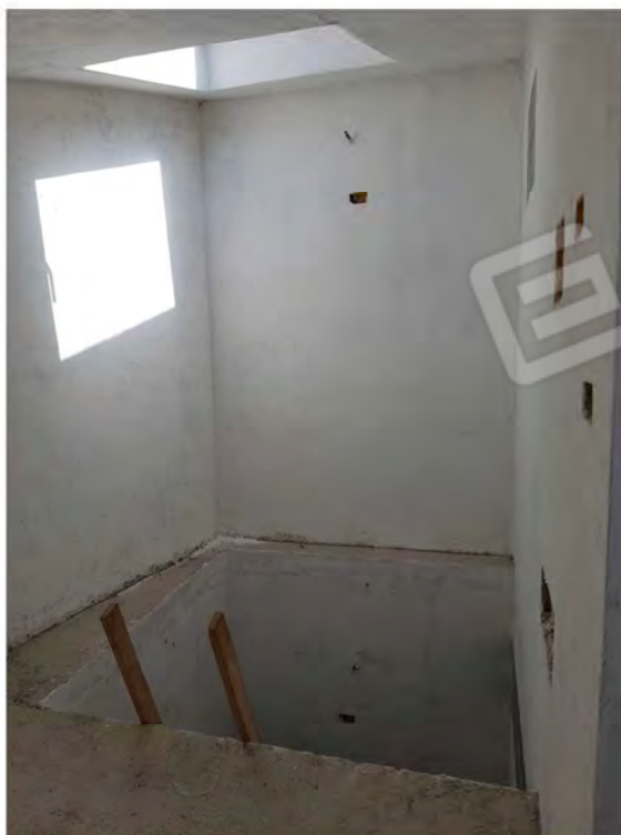
Figura 10 – Vano scale secondo piano
