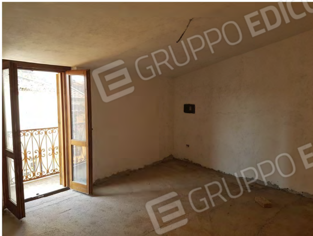
Figura 7 – Camera primo piano
