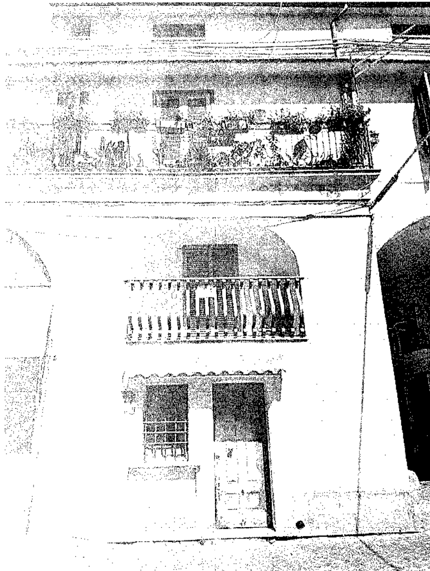
Figura 4 - Ingresso lato ovest
