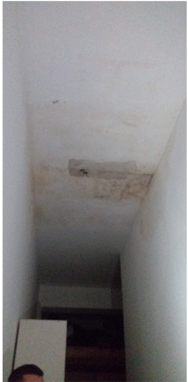
FOTO N° 13 – vano di accesso alla cantina
