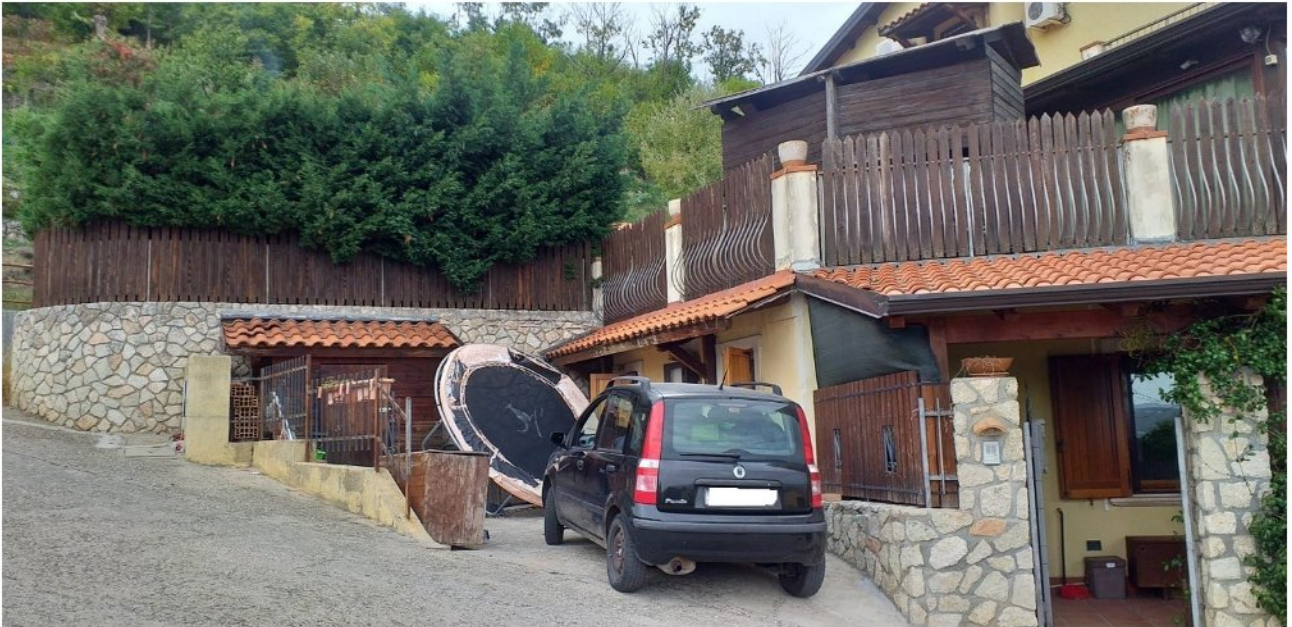
FOTO N° 2 – Fabbricato sito in Cerisano in via Savotani prospetto principale
