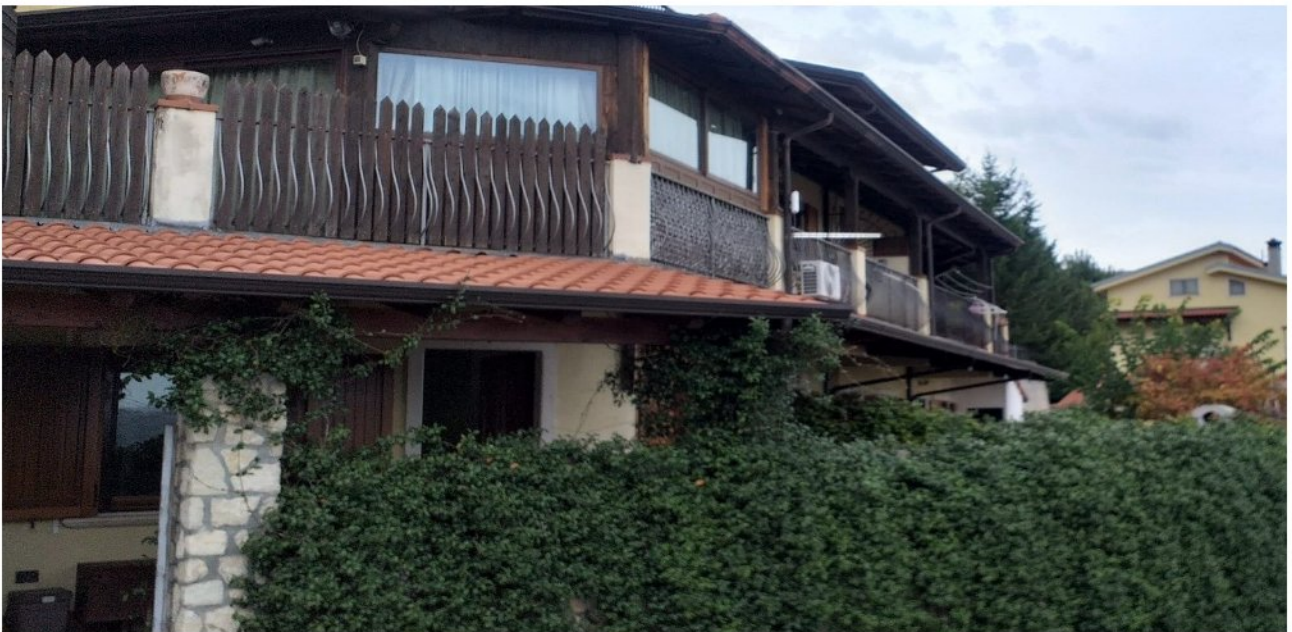
FOTO N° 1 – Fabbricato sito in Cerisano in via Savotani prospetto principale
