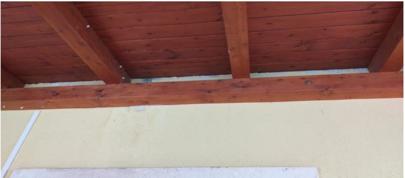
FOTO N° 5 – Particolare della tettoia
