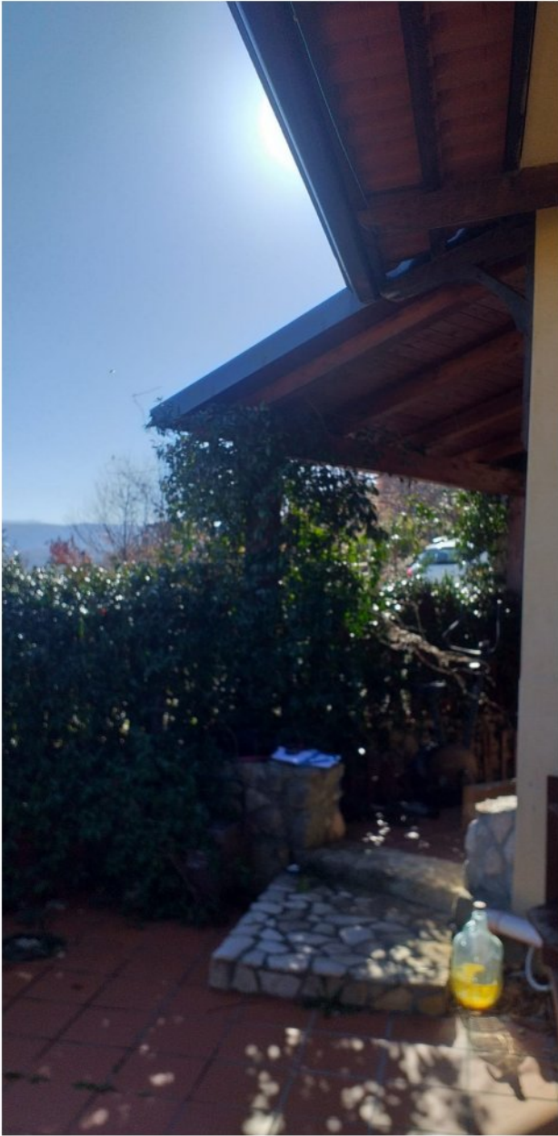
FOTO N° 9 – Particolare delle tettoie
