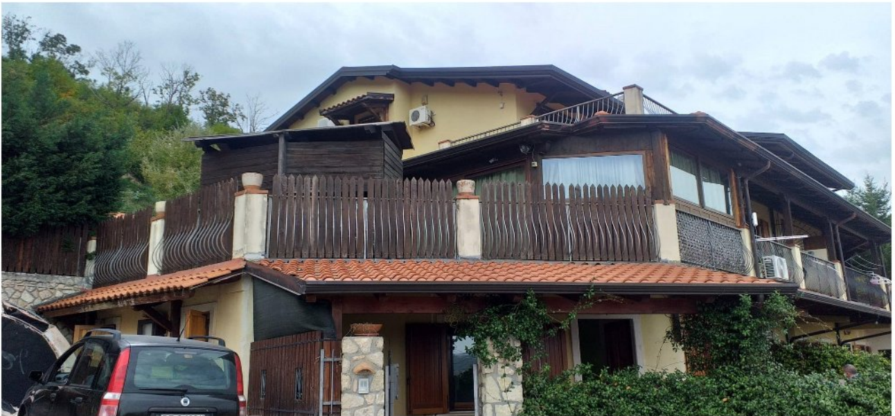
FOTO N° 3 – Fabbricato sito in Cerisano in via Savotani prospetto principale
