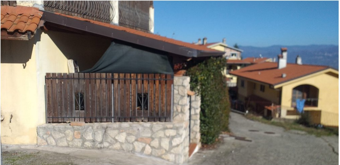
FOTO N° 4 – Fabbricato sito in Cerisano in via Savotani prospetto principale
