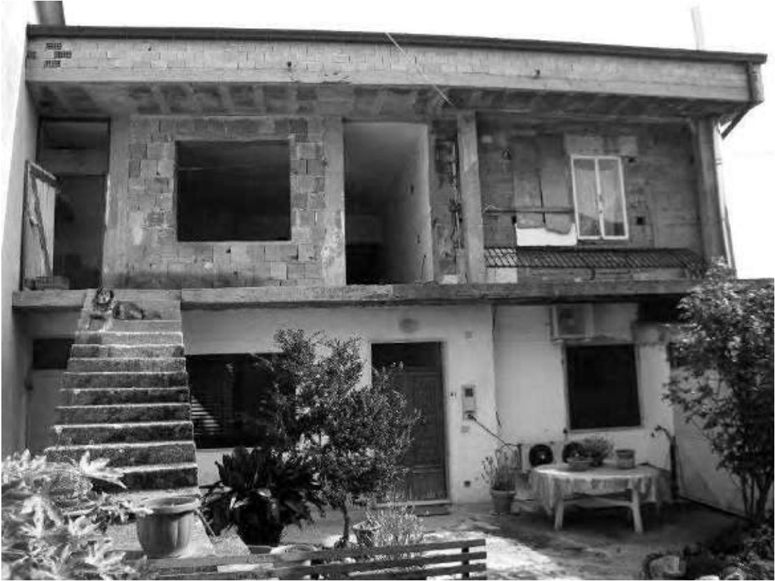
Foto n° 1 - Vista esterna lato nord
