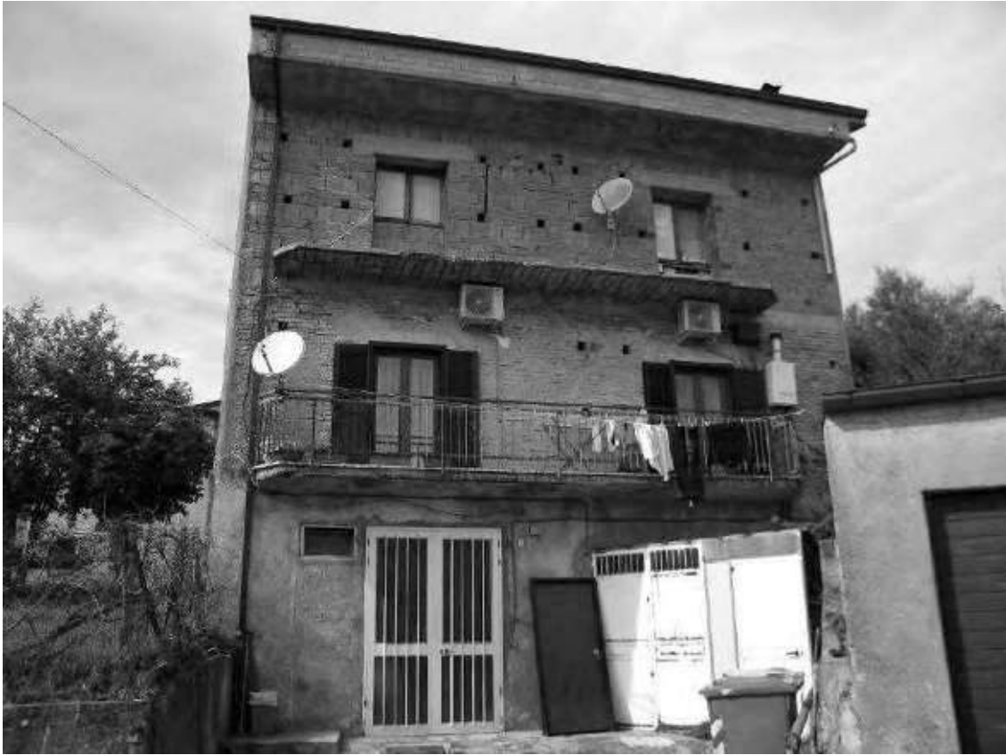
Foto n° 3 e 4 - Vista esterna lato sud
