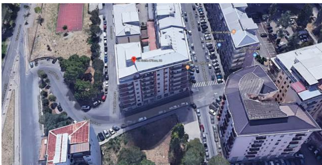
Localizzazione dell'immobile in ambito urbano.
