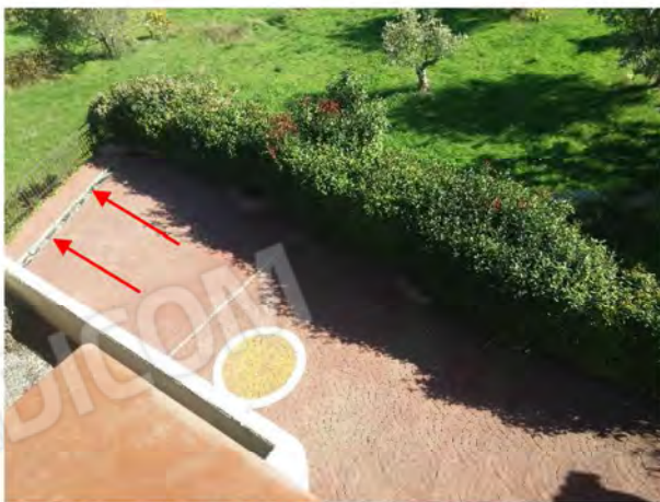
Foto 15: Vista dall'alto della corte zona Nord. Lesioni evidenti e distacco nei pressi della griglia di raccolta acque meteoriche
