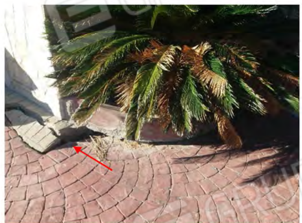
Foto 16: Spigolo Nord-Est fabbricato. Lesioni pavimentazione
