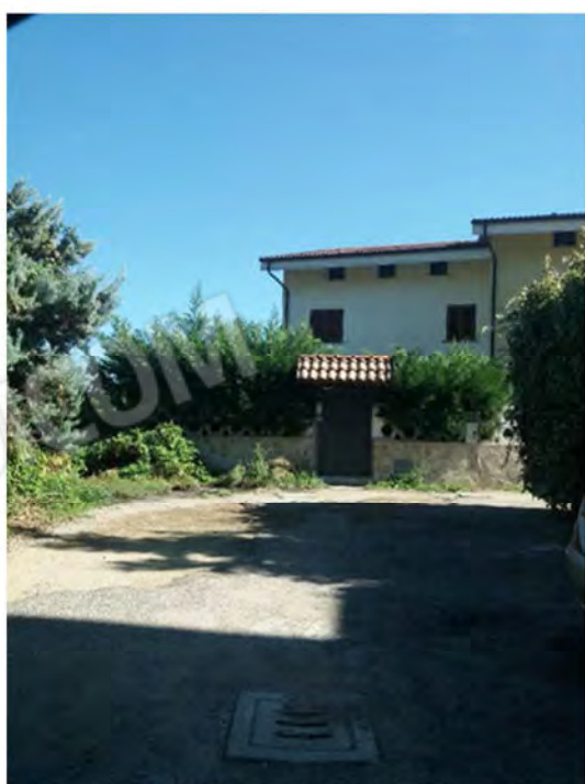
Foto 3: Prospetto Ovest – Ingresso all’immobile dalla corte condominiale
