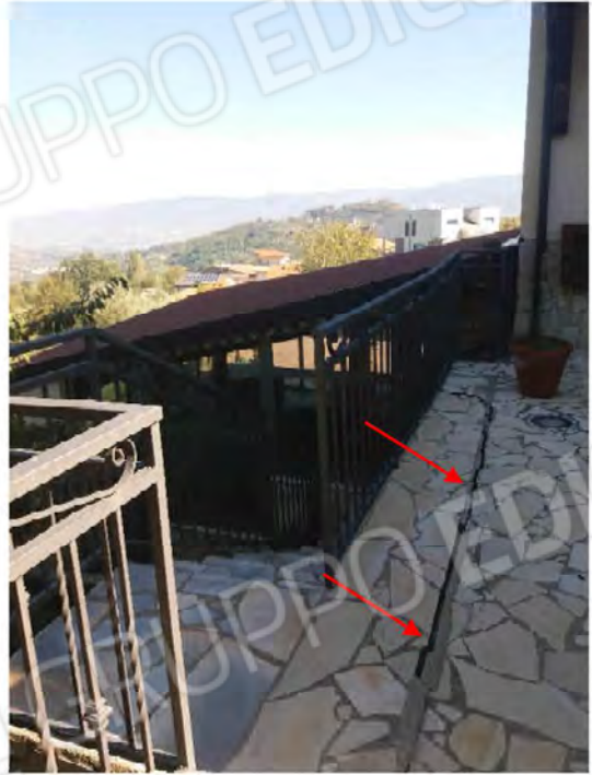
Foto 18: Corte d'ingresso lato Ovest. Lesioni alla pavimentazione
