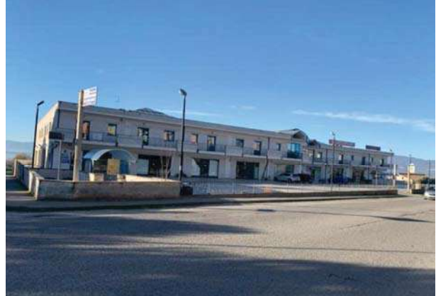
Vista generale del compendio da Corso d'Italia
