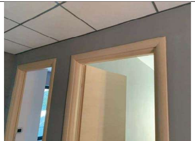
Vista primo locale dell'ufficio/studio – infisso interno
