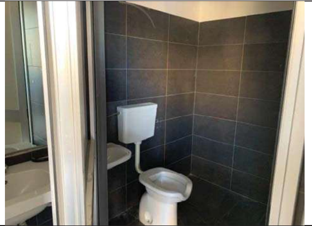
Vista interna del locale commerciale – bagno
