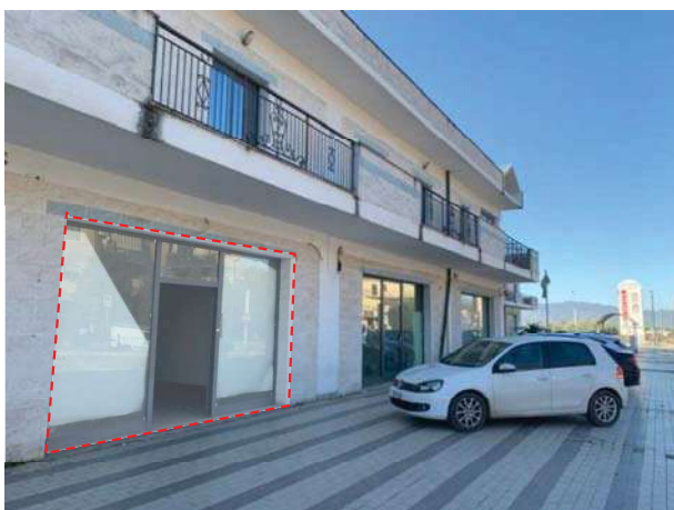
Vista dell'accesso dalla corte esterna
