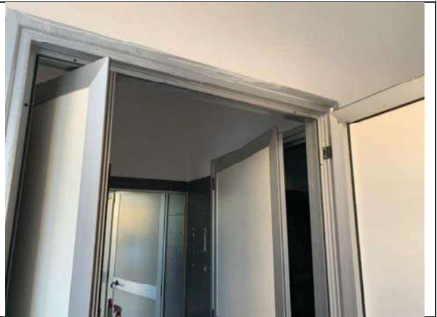
Vista interna del locale commerciale – infissi
