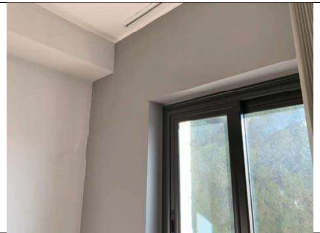
Vista primo locale dell'ufficio/studio – infisso esterno
