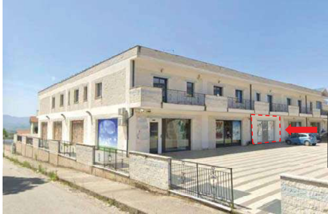
Vista generale del compendio di immobili con individuazione del cespite n. 1
