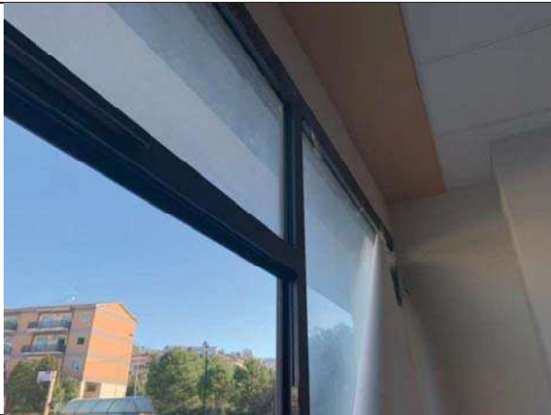
Vista interna del locale commerciale – infissi
