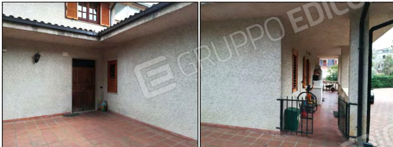
Foto 1-2: Vista villetta – ingresso appartamento Fgl. 1 p. 101 sub 1.
