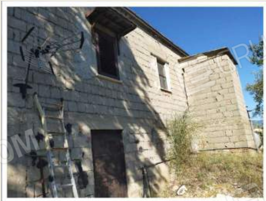
FOTO N° 18 - MAGAZZINO - FOGLIO 9 - PARTICELLA 203 - SUB 1
