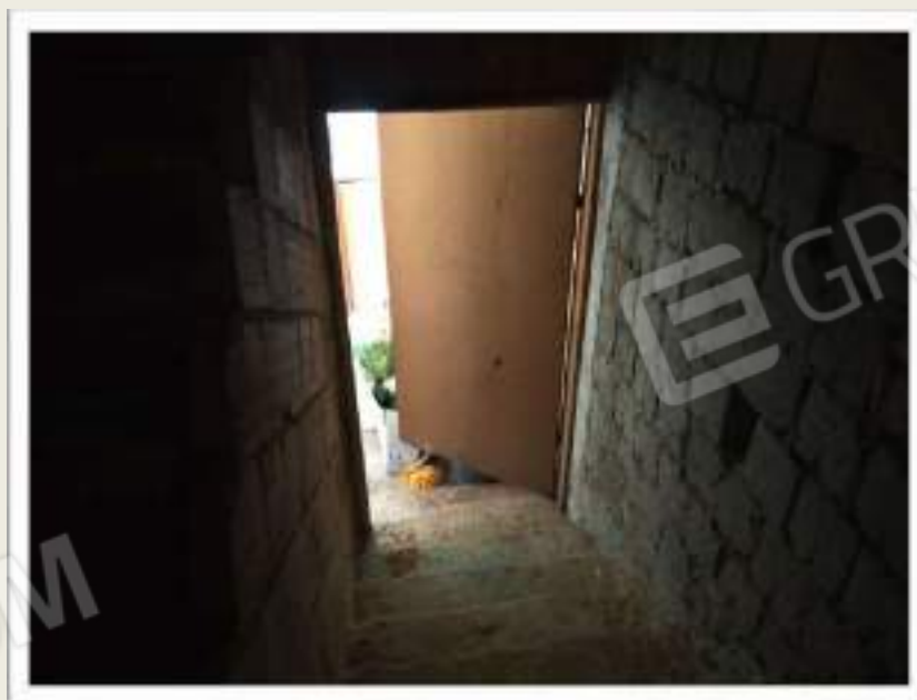
FOTO N° 14 - SCALA ACCESSO SOTTOTETTO - FOGLIO 9 - PARTICELLA 202 - SUB 1
