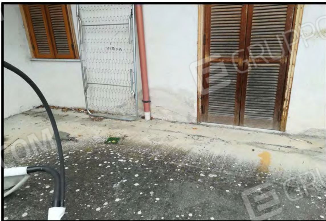
PARTICOLARE ESTERNO UMIDITA PER RISALITA CAPILLARE SULLE MURATURE E INFISSO ESTERNO
