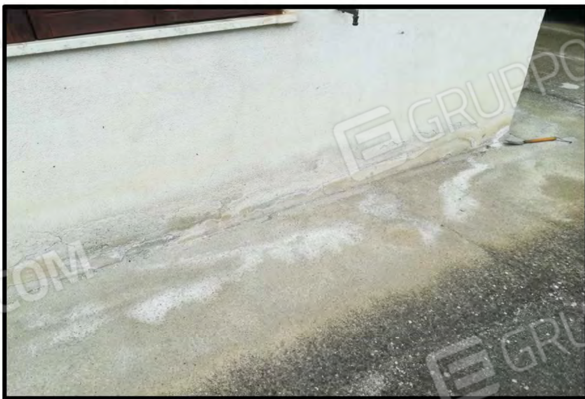
PARTICOLARE ESTERNO UMIDITA PER RISALITA CAPILLARE SULLE MURATURE
