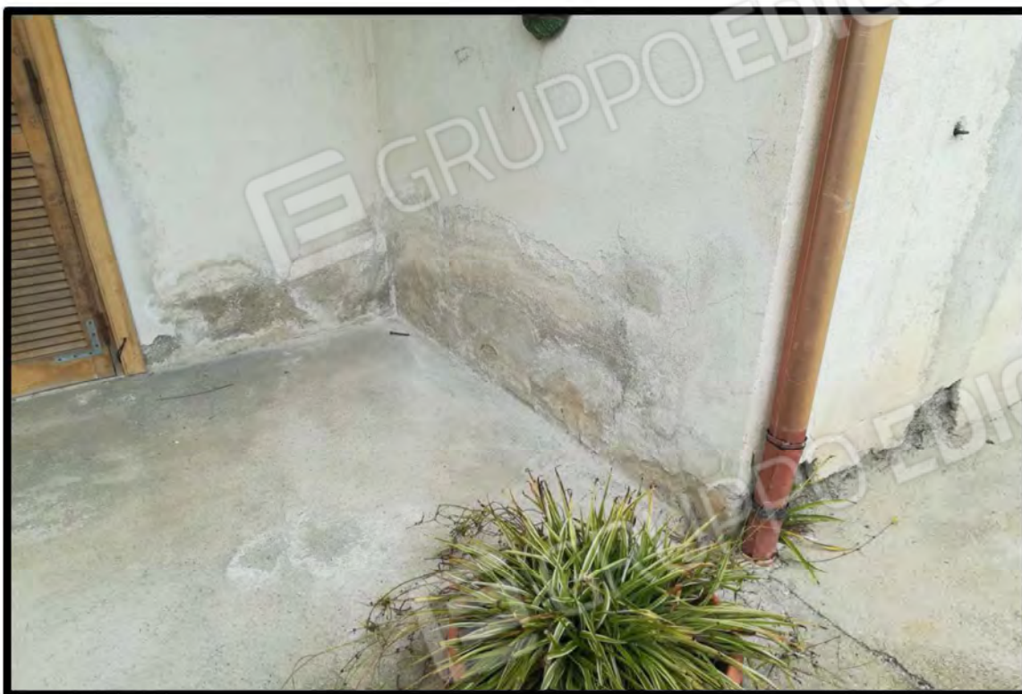
PARTICOLARE ESTERNO UMIDITA PER RISALITA CAPILLARE SULLE MURATURE
