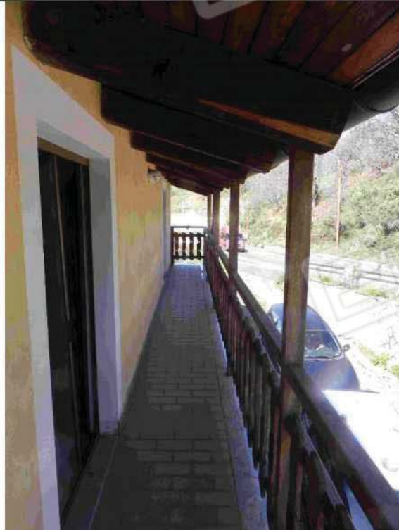
Fabbricato ubicato in Rose alla Contrada Stio Foglio 25 part. 14 sub 1 piano Primo terrazzo
