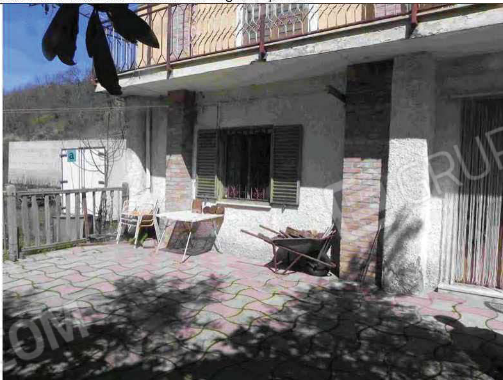
Fabbricato ubicato in Rose alla Contrada Stio Foglio 25 part. 14 – ingresso Sub 2
