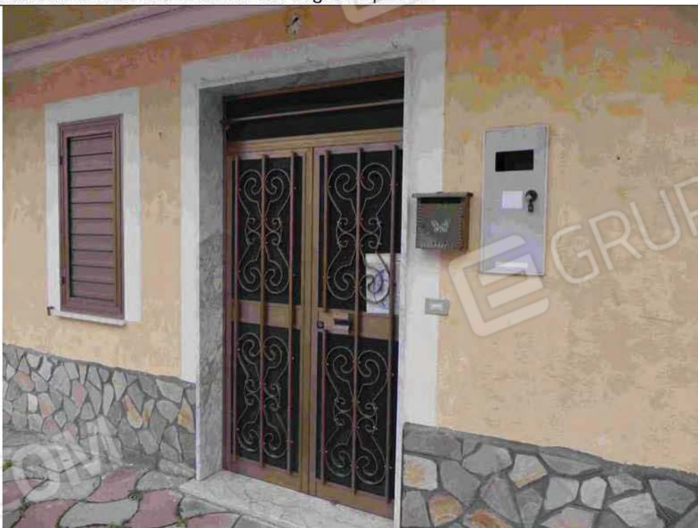
Fabbricato ubicato in Rose alla Contrada Stio Foglio 25 part. 14 – ingresso Sub 1
