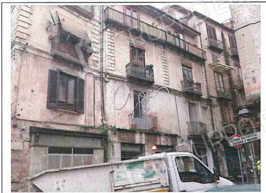
FOTO 1 – Prospetto su Corso Telesio dell'intero fabbricato
