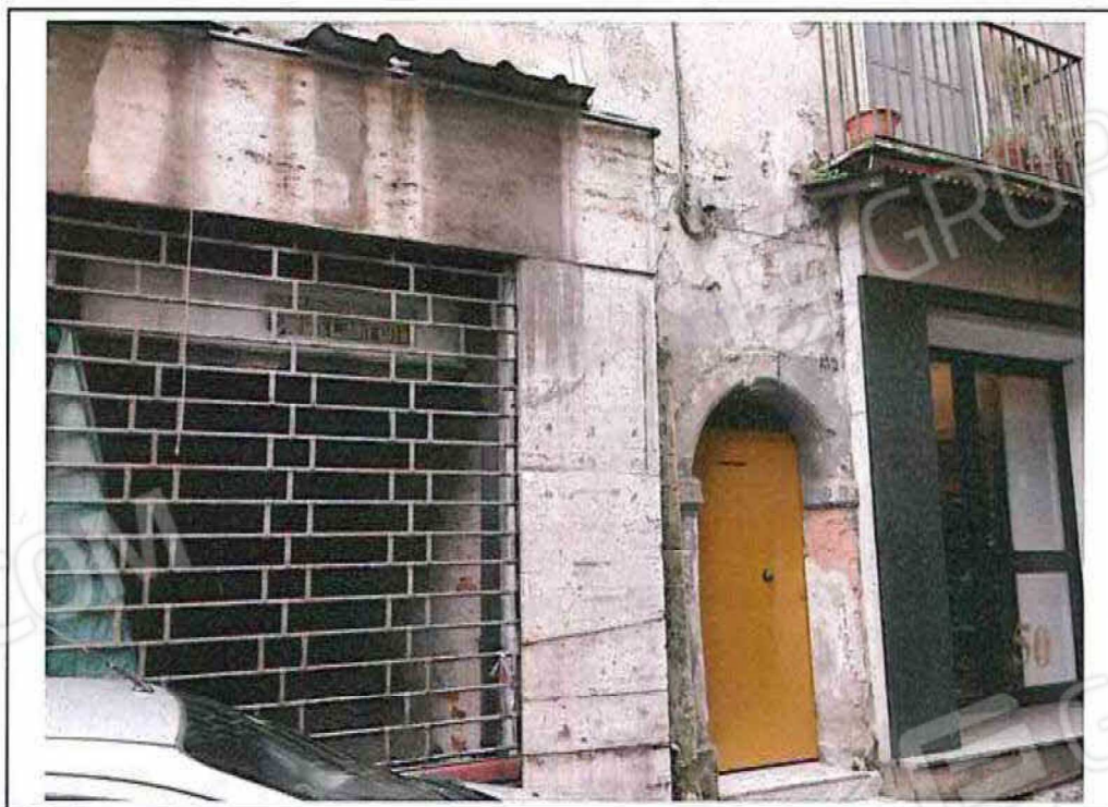
FOTO 4 – Portone di ingresso al Fabbricato
