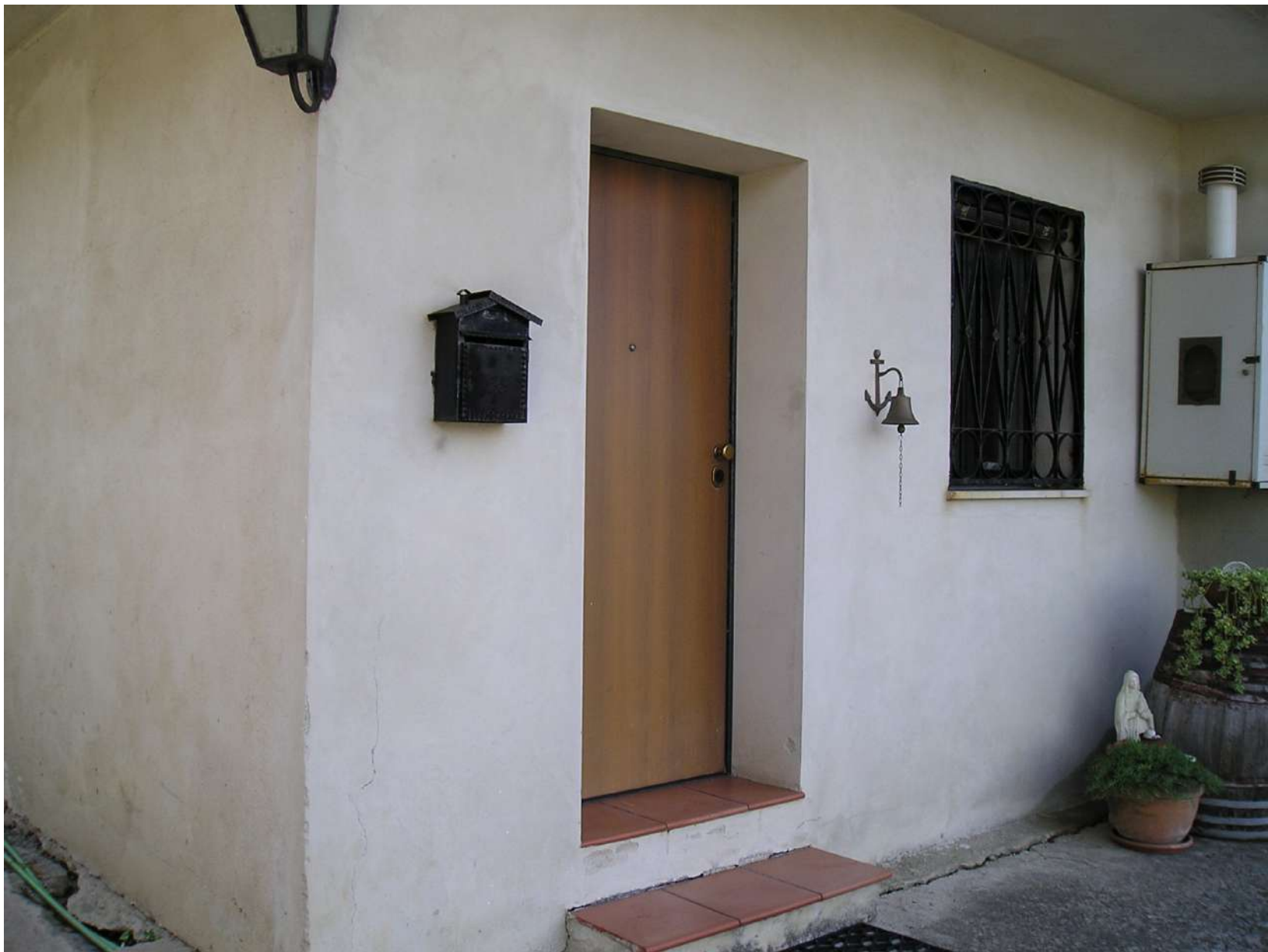
Foto n. 10: Portoncino esterno di accesso al piccolo appartamento ubicato al piano terra
