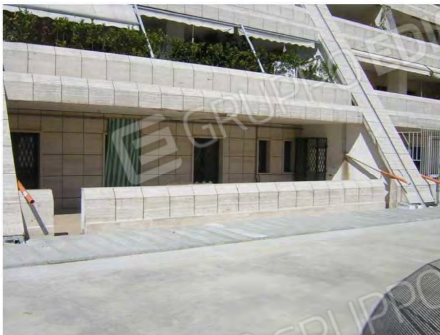
Foto 15. Appartamento, terrazzo Sud.
