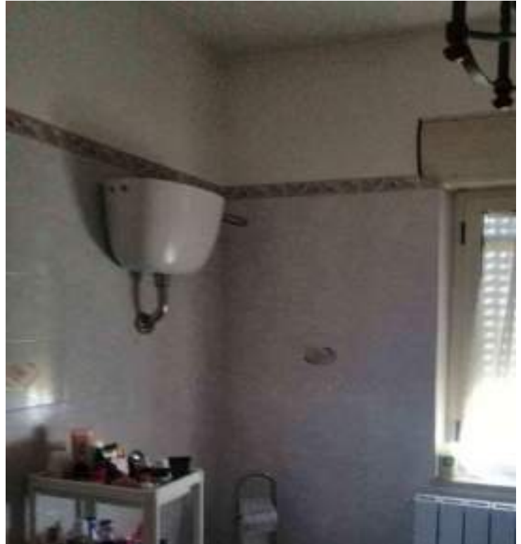
Fig.15-16 ) Particolare dei bagni
