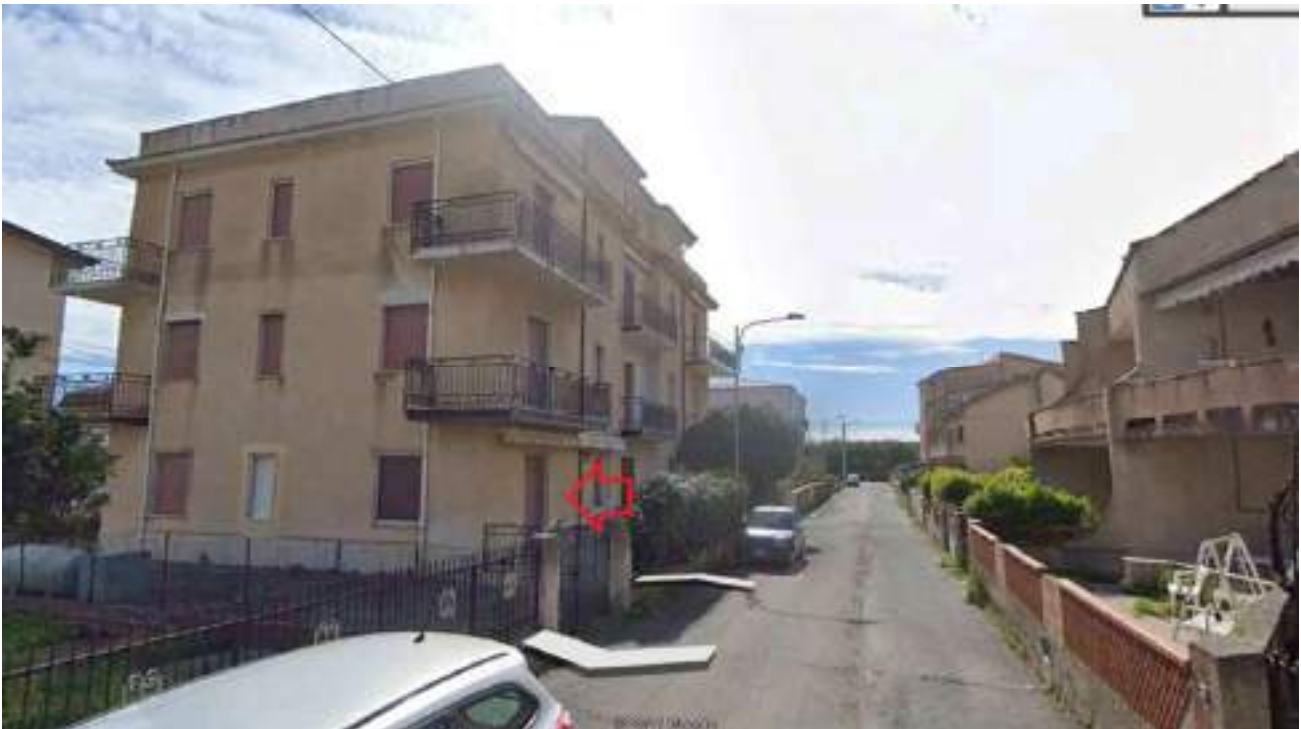
Fig.24) Esterno del fabbricato ed individuazione dell'unità immobiliare in oggetto
