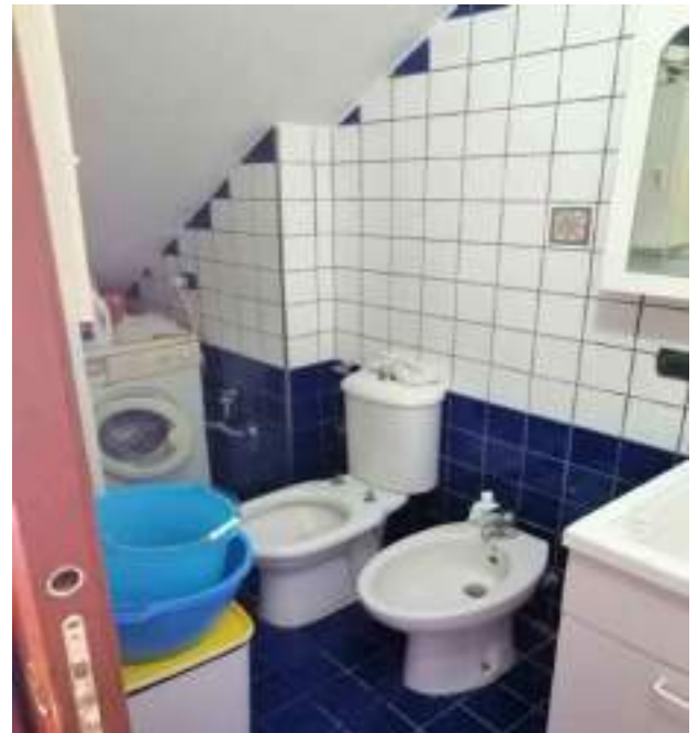
Fig.64) Particolare del bagno al piano interrato
