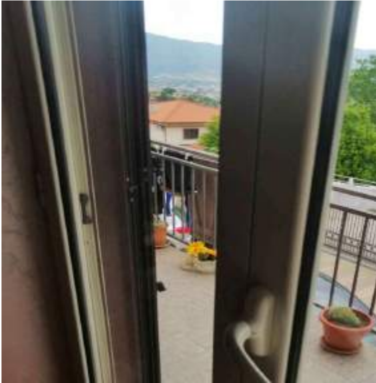
Fig.51) Particolare infisso esterno
