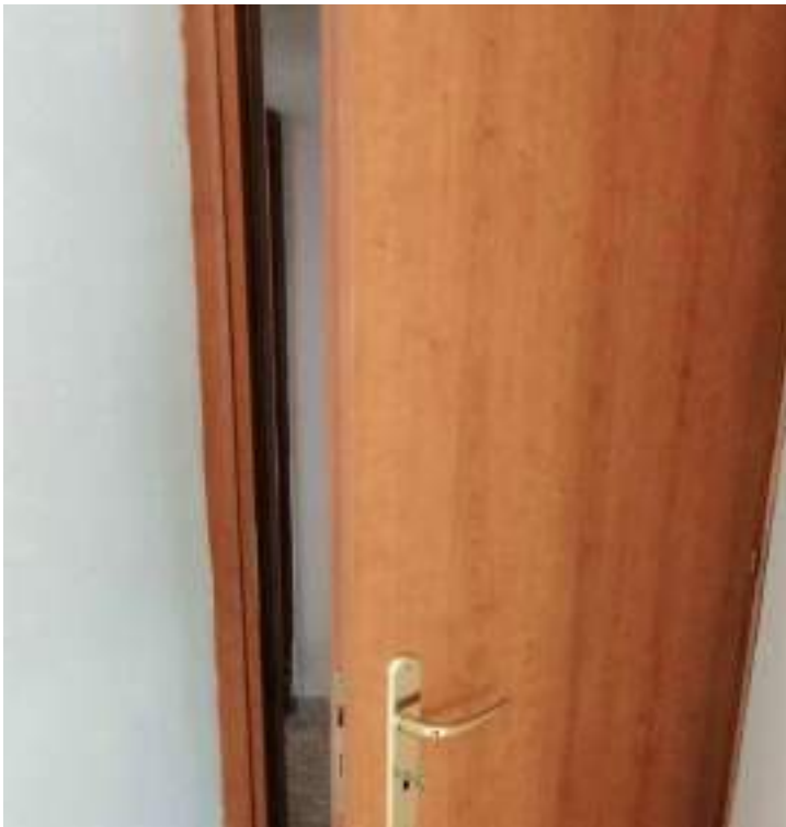
Fig.27) Particolare delle porte interne
