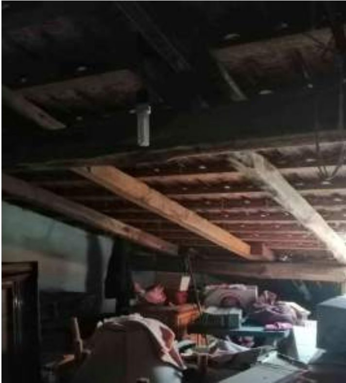
Fig.21-22) Interno della soffitta
