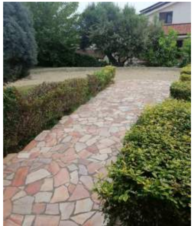
Fig.50) Particolare della pavimentazione della scala di accesso all'U.A.
