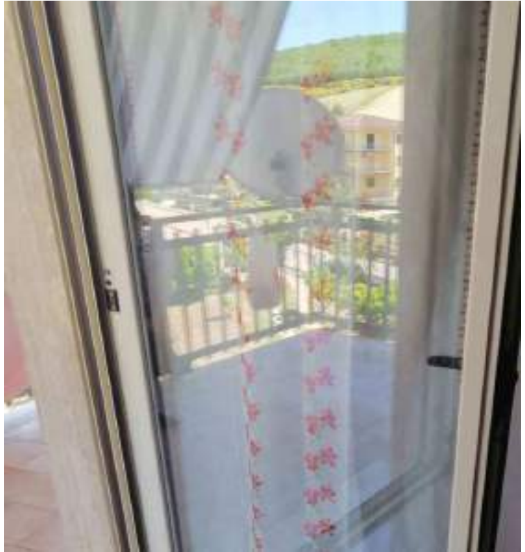
Fig.19) Particolare infisso esterno
