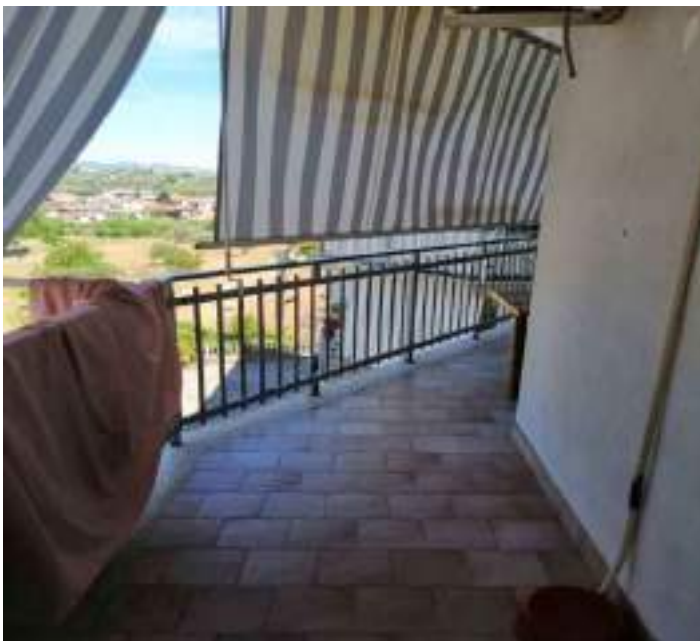
Fig.20) Particolare pavimentazione balcone
