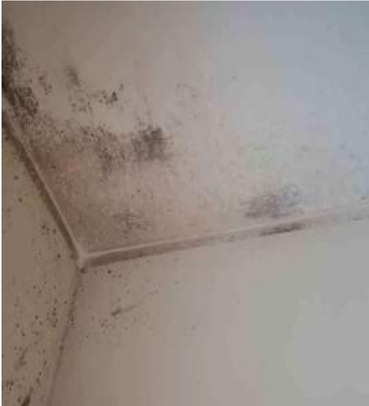
Fig. 17-18) Particolare tracce di umidità, infiltrazioni d'acqua e muffe presenti sulle pareti
