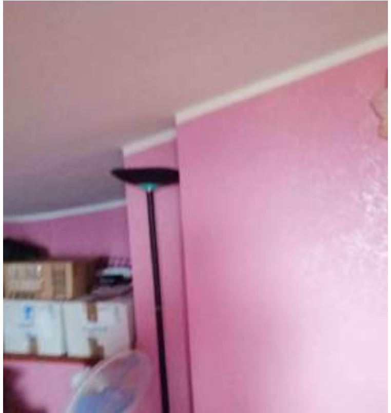
Fig.55 - 56) Particolare dell'interno del piano sottotetto
