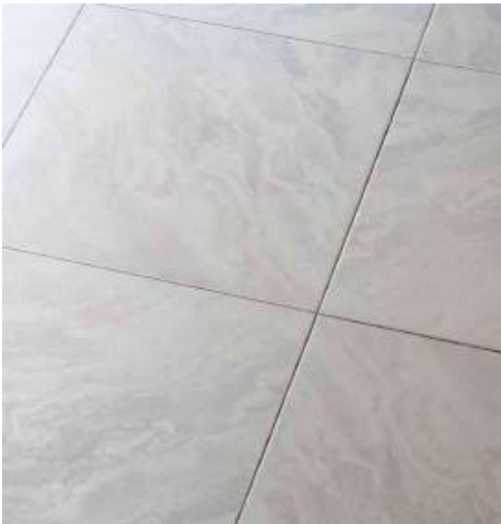
Fig. 12) Particolare della pavimentazione interna
