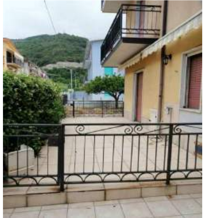
Fig.40) particolare del balcone sul fronte nord
