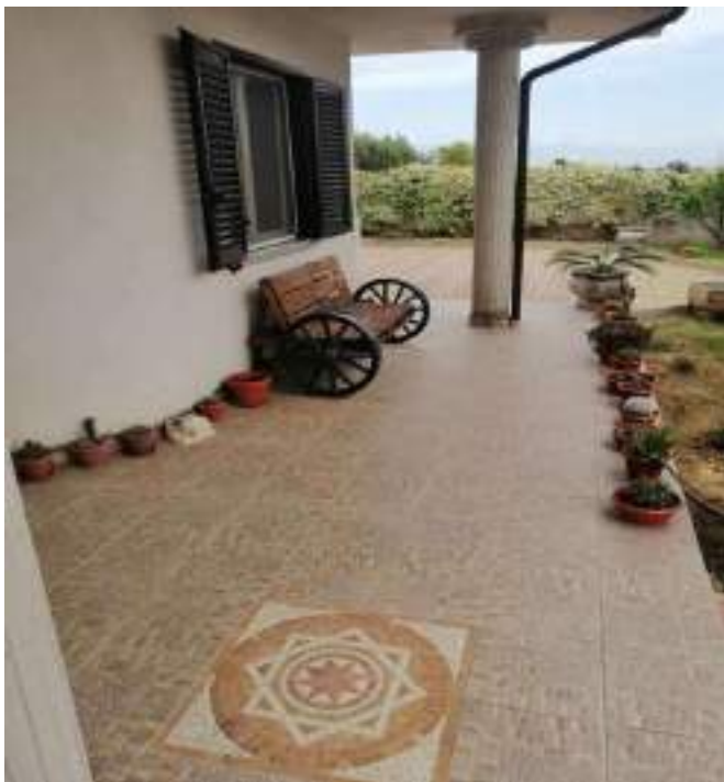
Fig.48) Particolare del portico esterno
