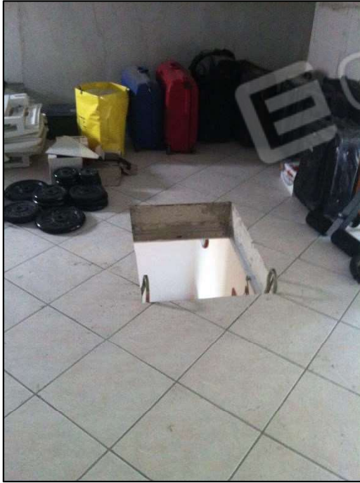
FOTO 43 e 44 (interni piano sottotetto)
