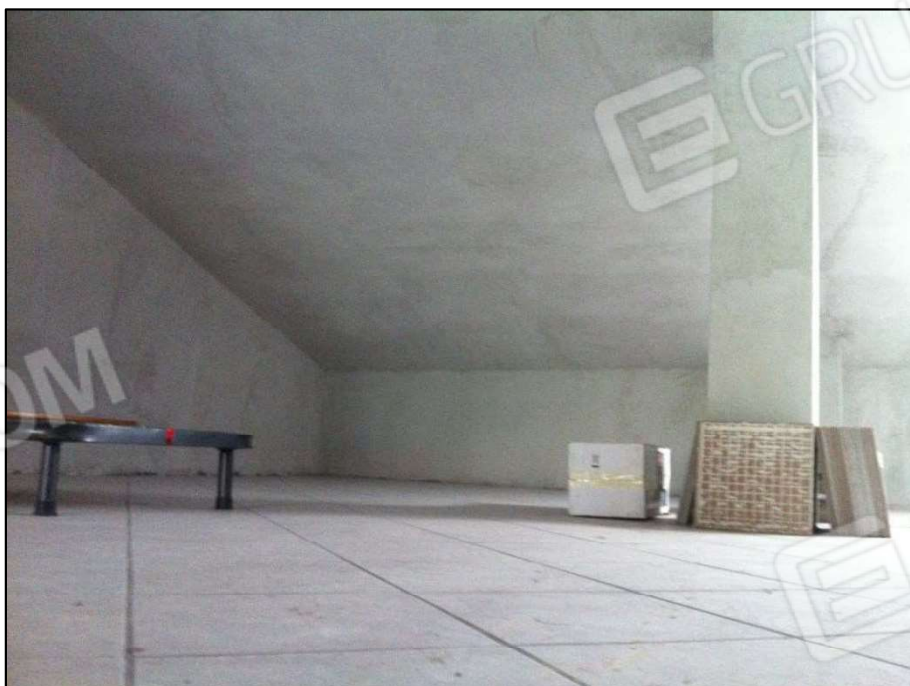
FOTO 40 (interni piano sottotetto)
