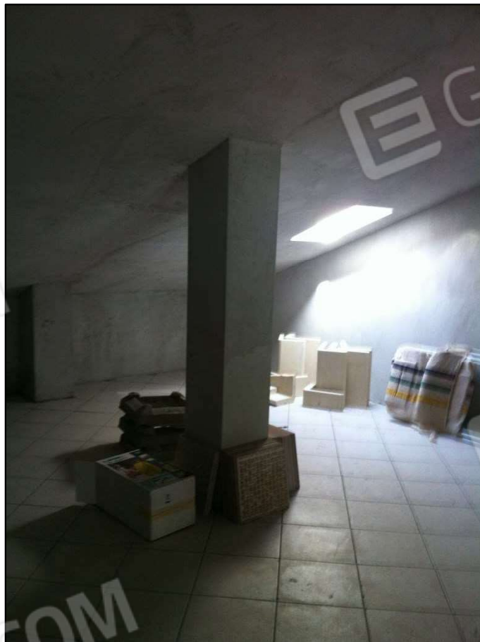
FOTO 45 (interni piano sottotetto)
