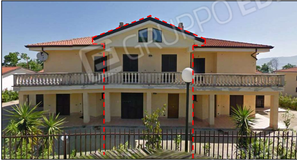
FOTO 4 (esterni lato Sud-Ovest piano terra)
