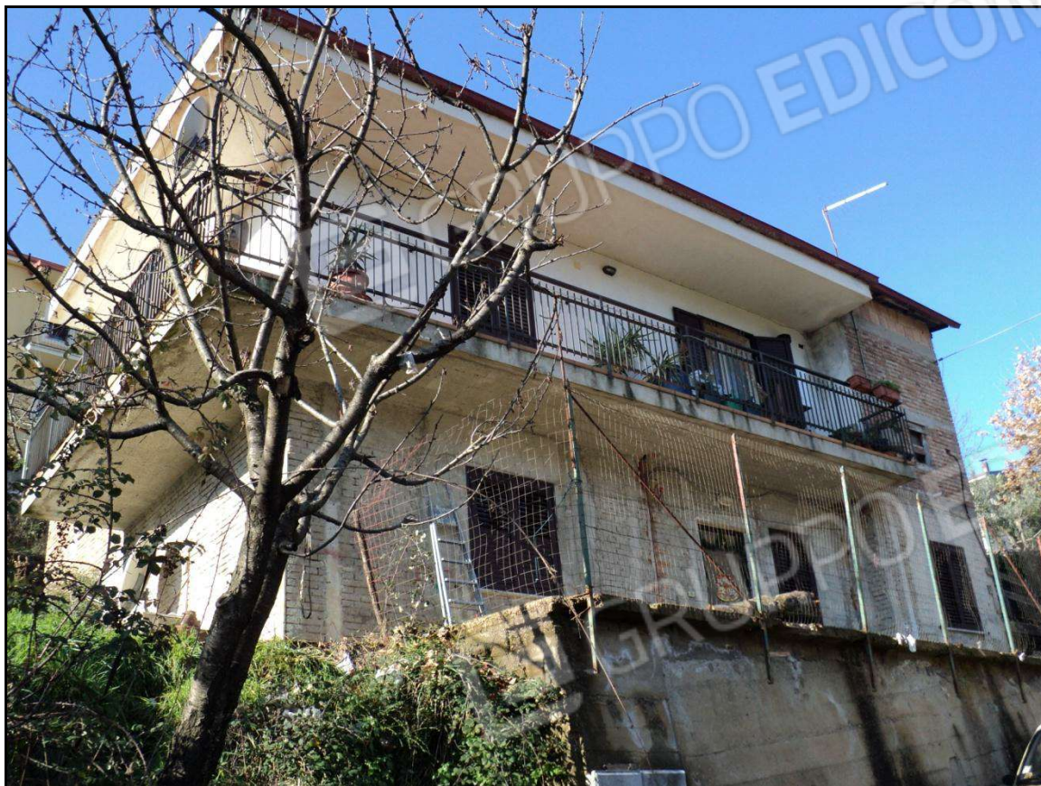
Foto N° 1 – Prospetto principale del fabbricato dove è sito l'appartamento oggetto di stima.
