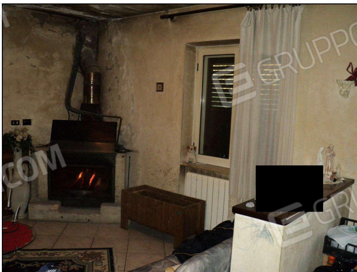
Foto NN° 6,7 – Soggiorno con termocamino ed evidenti tracce di umidità e muffa.
