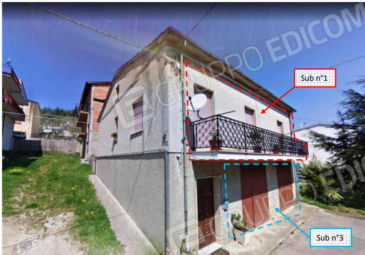
Foto n°3: –Vista dall’angolo Sud del fabbricato in catasto urbano del Comune Acri (CS), fg. n°85, p.lla 864;
