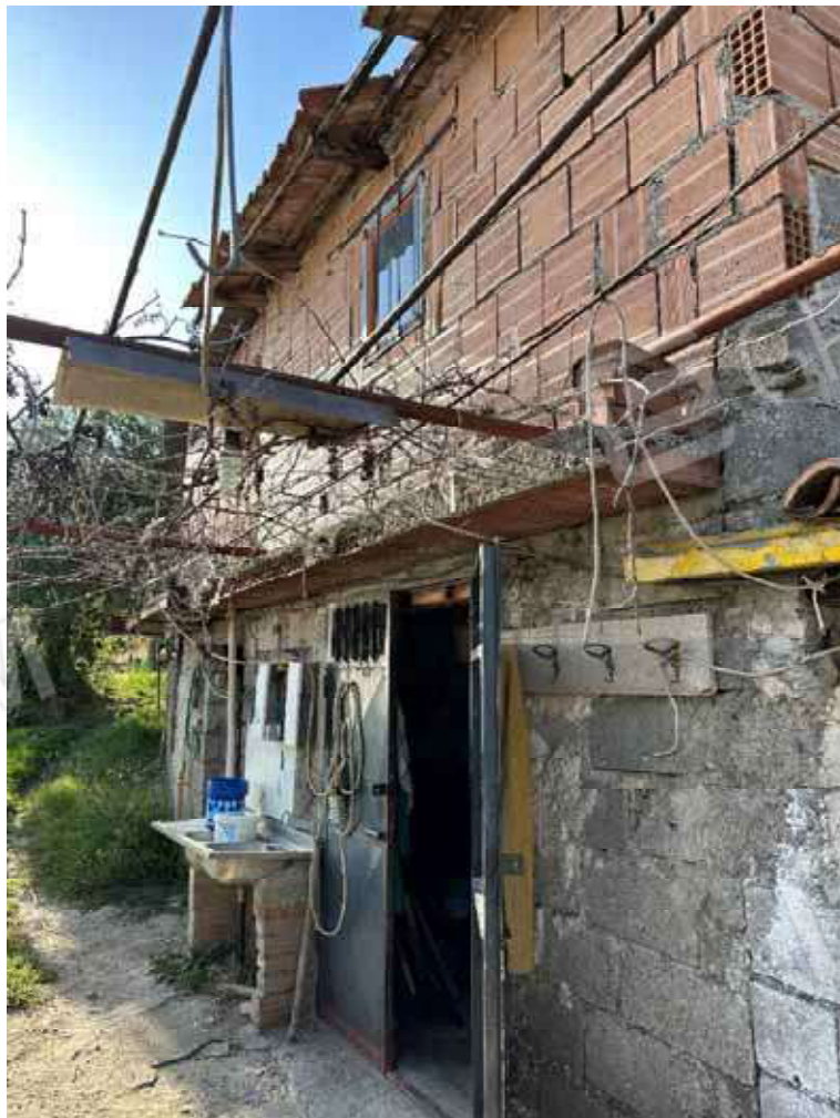
Foto 26: vista esterna fg. 4 p.lla 364 sub 2
