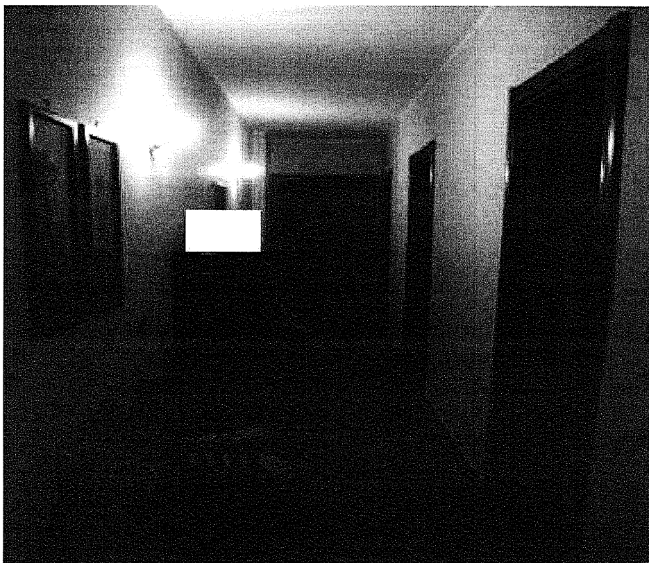
FOTO N. 7 – Piano primo, disimpegno
