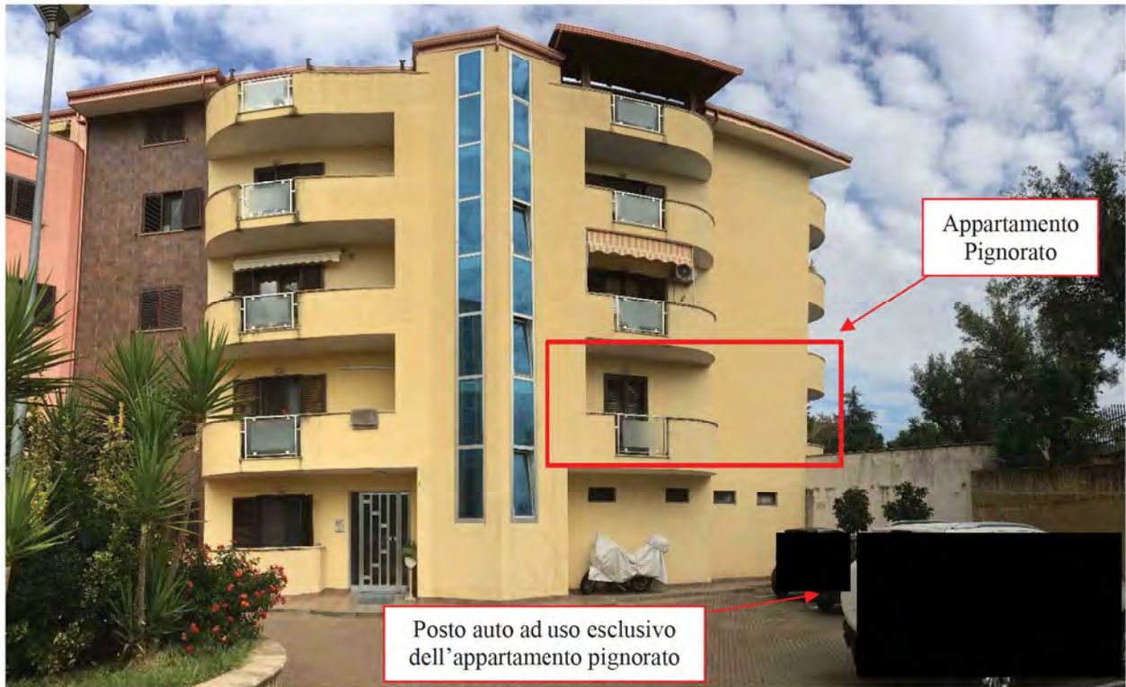
Figura 2: Edificio all'interno del quale sono ubicati gli immobili pignorati- vista dal cortile interno del fabbricato (lato sud).
