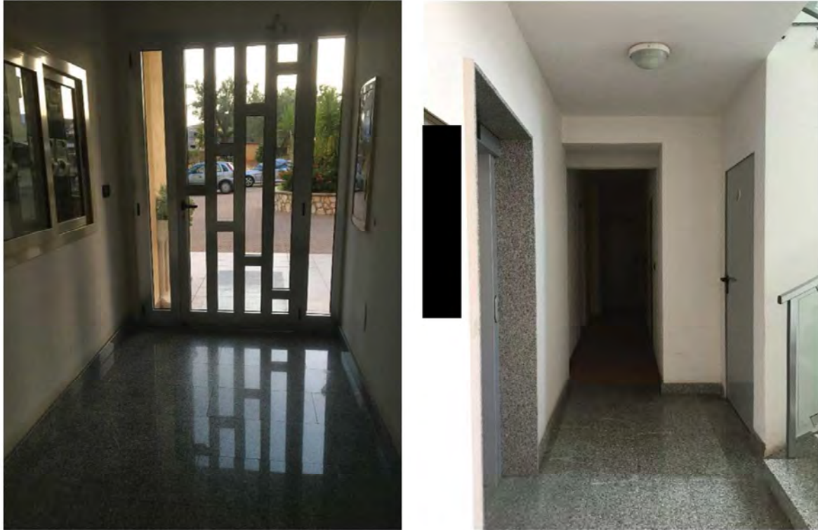
Figura 4: Edificio all'interno del quale sono ubicati gli immobili oggetto di pignoramento – viste dell'androne di ingresso all'edificio.
