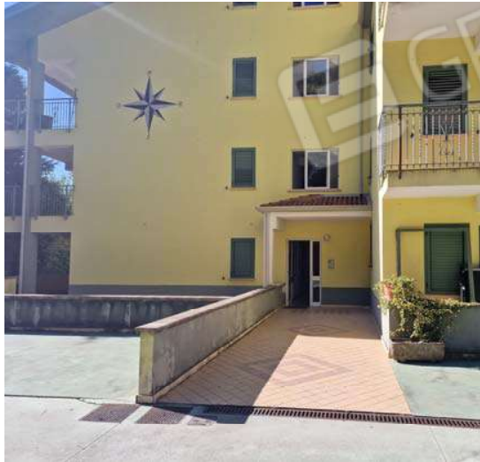
Ingresso scala condominiale
