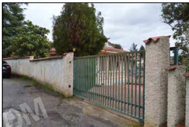
Foto 26: Vista esterna- muro perimetrale e cancello carrabile.
