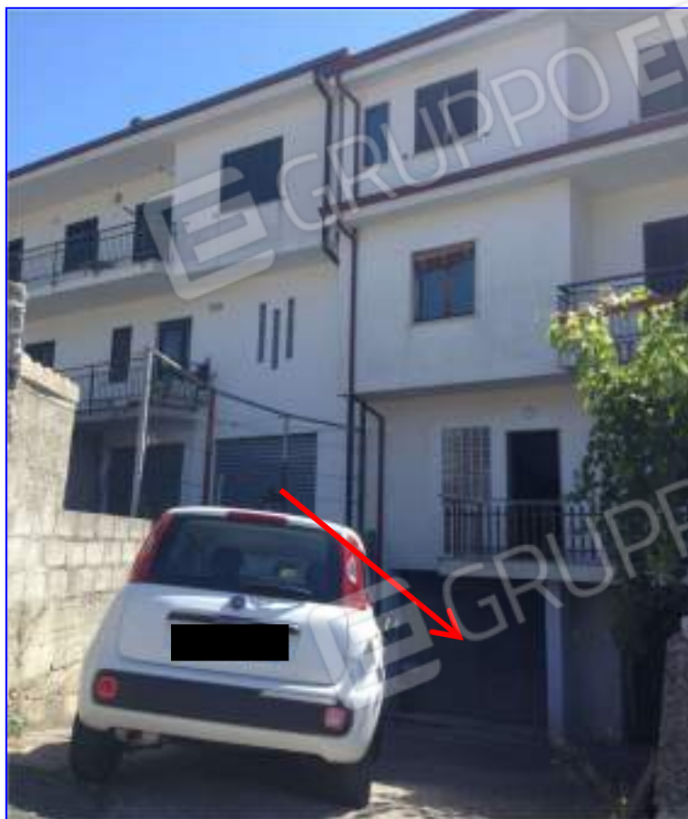
Foto 1 – Vista rampa di accesso e porta d'ingresso
