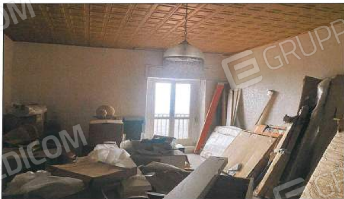
Foto n° 25 – Vista interna sala presente nella u.l. sub 7, sono presenti ottime rifiniture. In quanto l'u.l. ha avuto lavori di ristrutturazione visibile la controsoffittatura.
