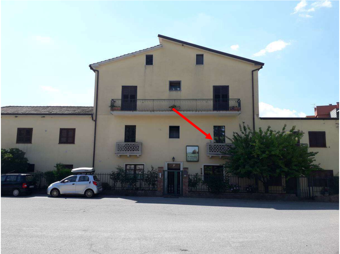
Foto N.1: Prospetto fabbricato lato Nord con ingresso.
