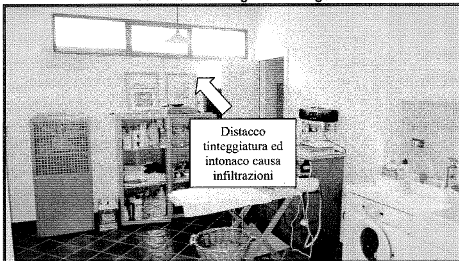
Foto 4 Seminterrato – Locale Lavanderia
