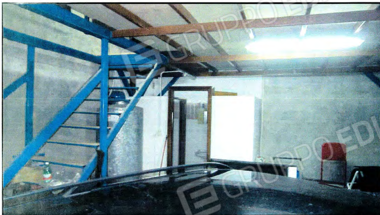
Foto A7 Interno del magazzino – Scala accesso al soppalco
