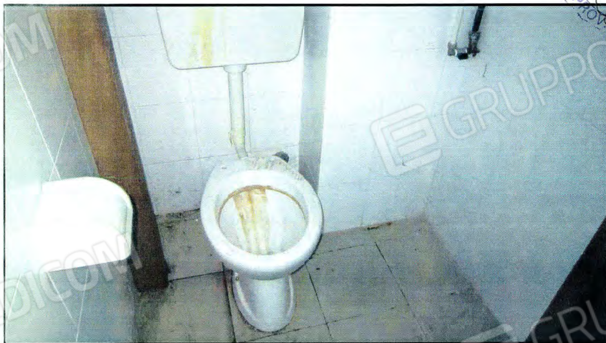
Foto A8 Interno del magazzino – Wc
