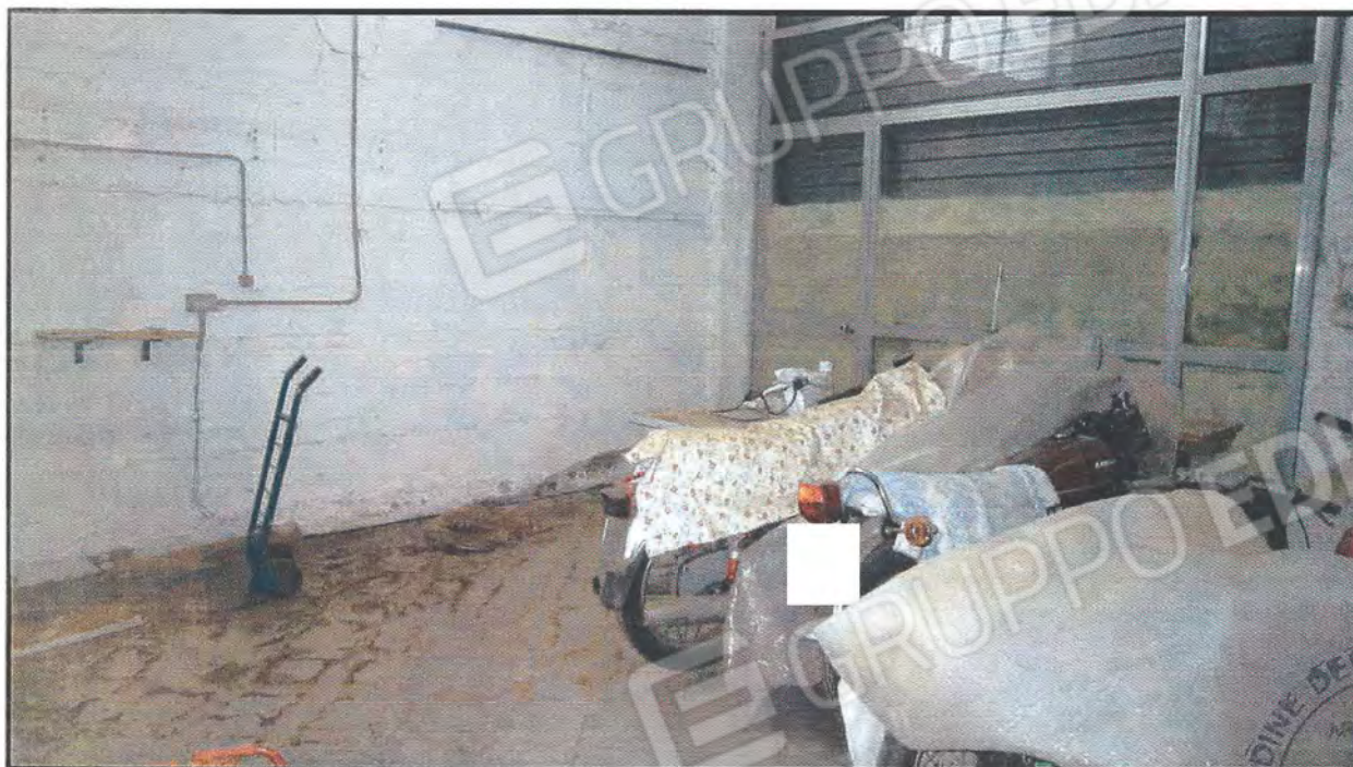
Foto A3 Interno del magazzino - Ingresso
