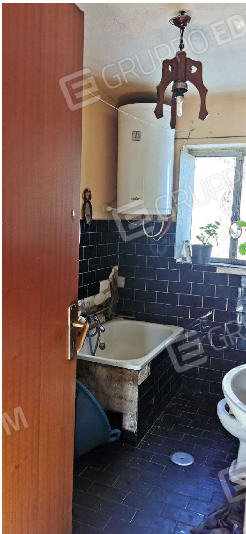
Foto 13: Casa per il personale - porzione 1 - WC.
