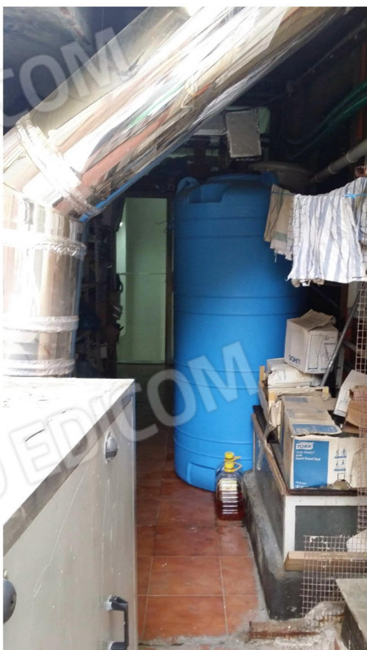
Foto n. 28 – terrazzo parte coperta
