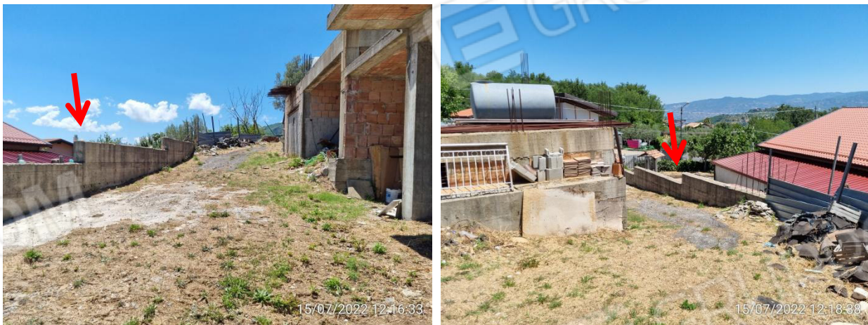
Foto 4.2_2 e 3 – Muro di sostegno in c.a
