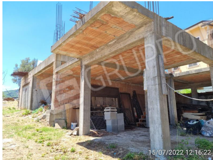
Foto 4.2_1 – Struttura in c.a.
