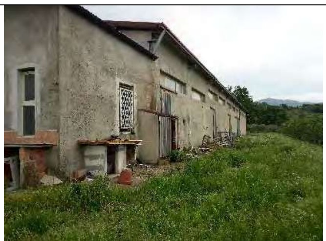
LATO SUD-OVEST CON LOCALE SERVIZI
