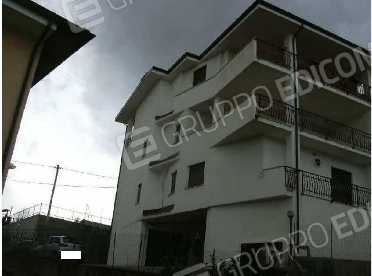
VISTA ESTERNA LATO EST
