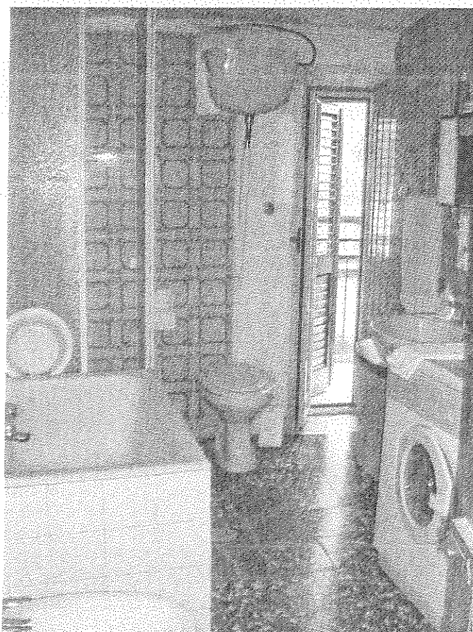
Fabbricato ad uso abitativo – Bagno
