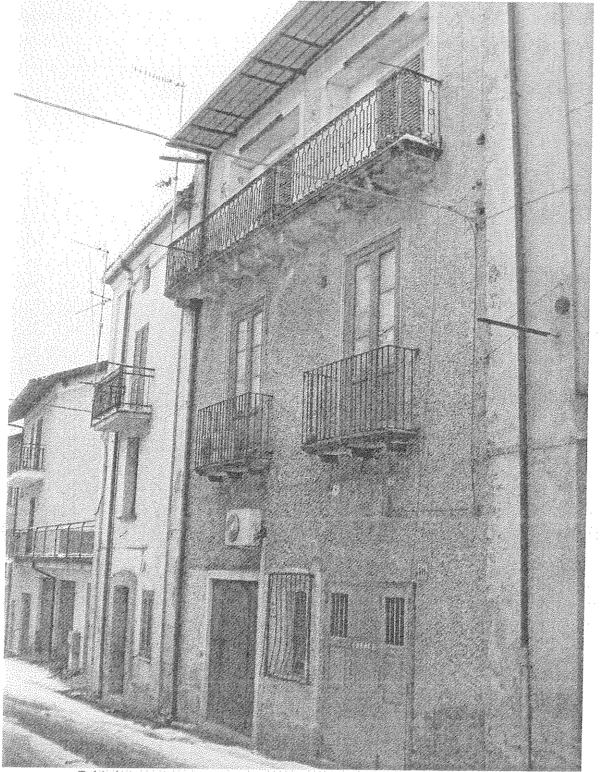
Fabbricato ad uso abitativo oggetto della perizia – Vista posteriore
