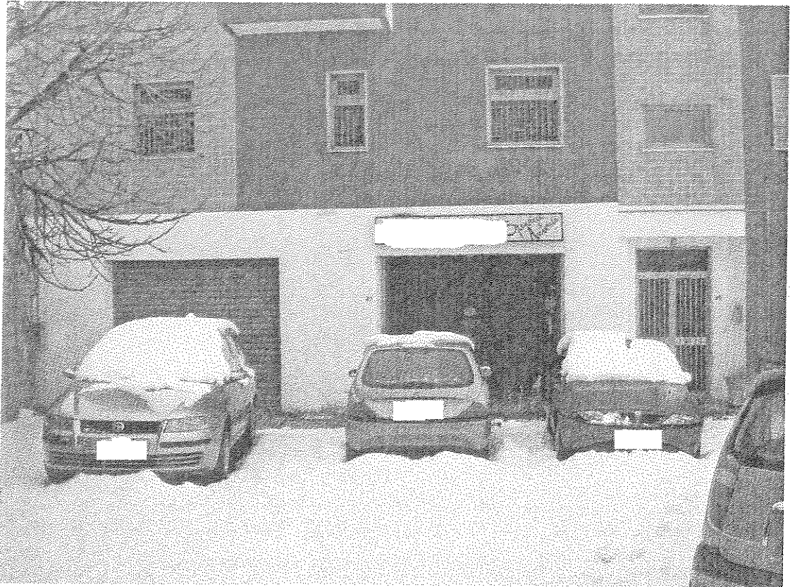
Locali commerciali ad uso deposito – Vista esterna
