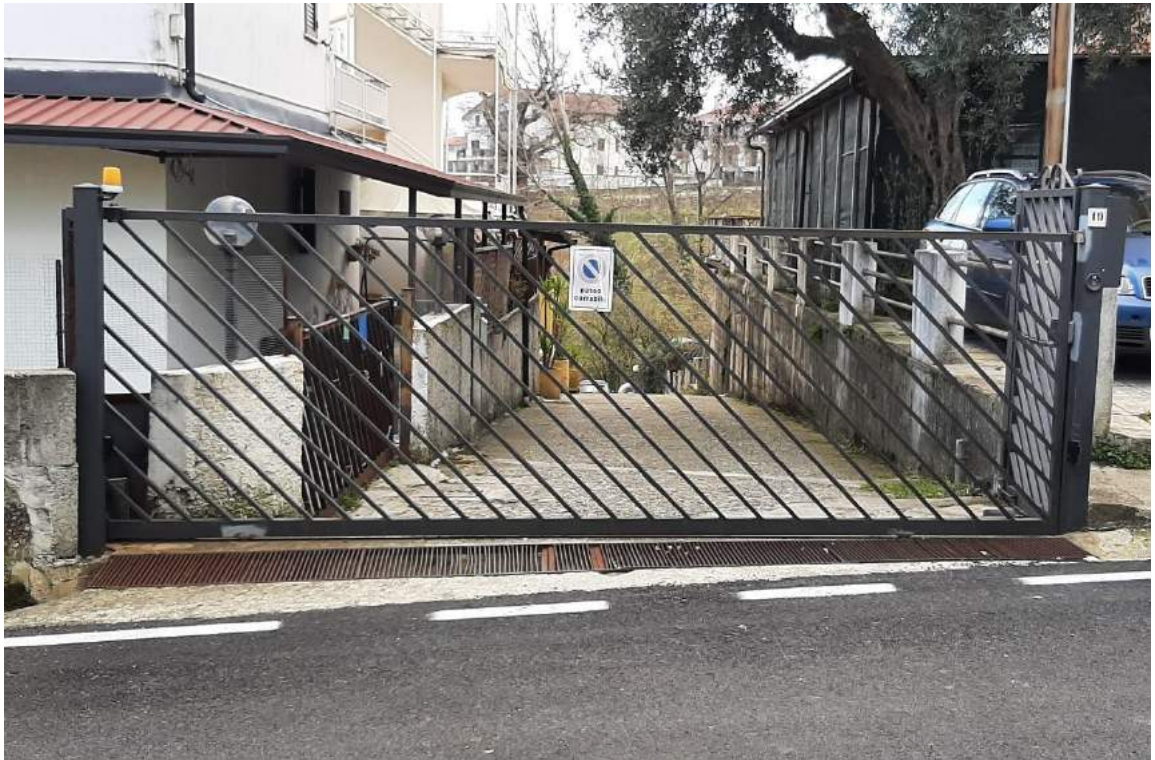
Foto 16. Cancelli di accesso all'area condominiale.
