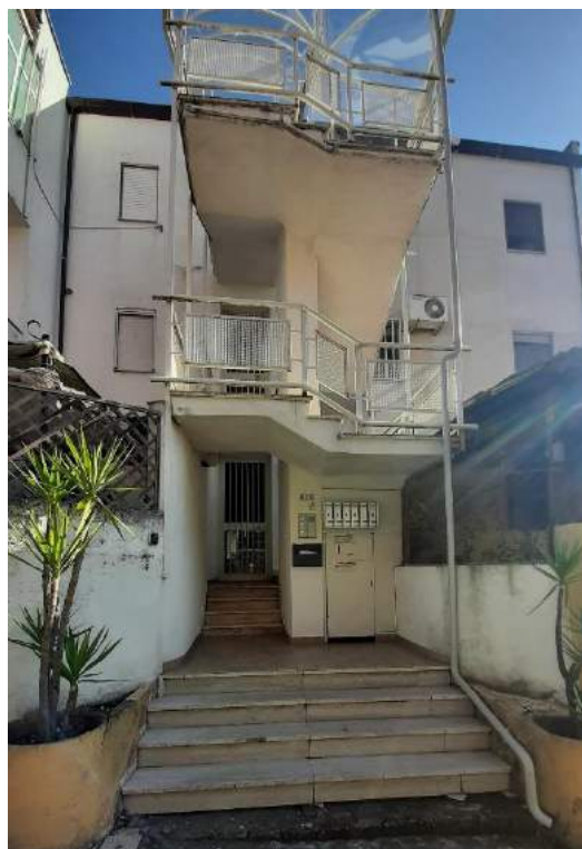
Foto 13. Vano scala comune.
