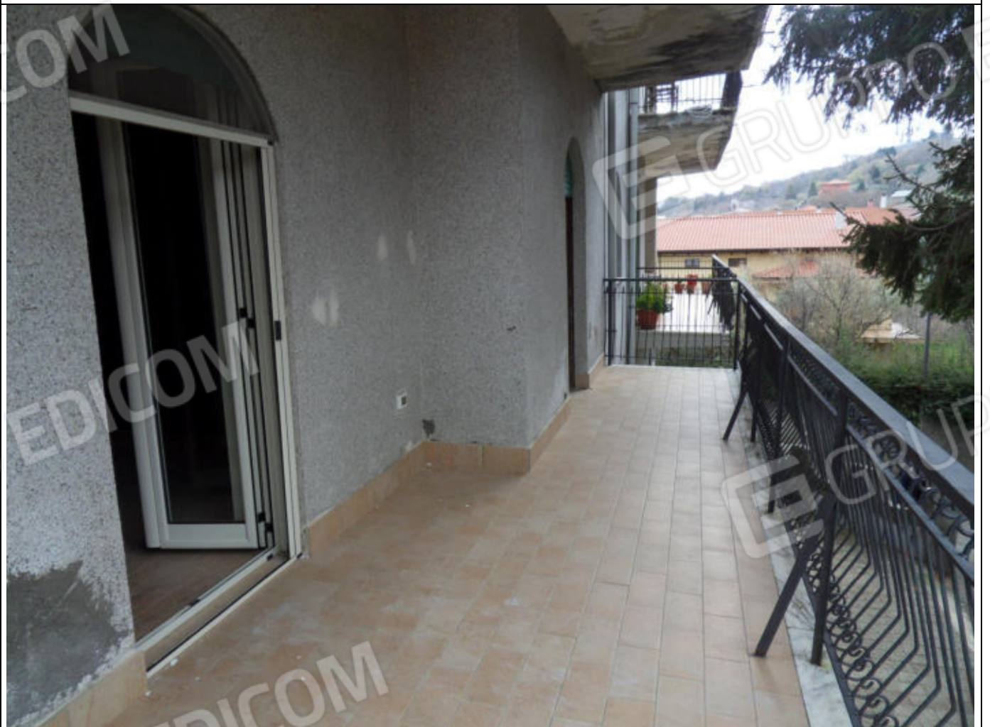
FOTO N. 38: Esterni (balcone) Bene Immobile
