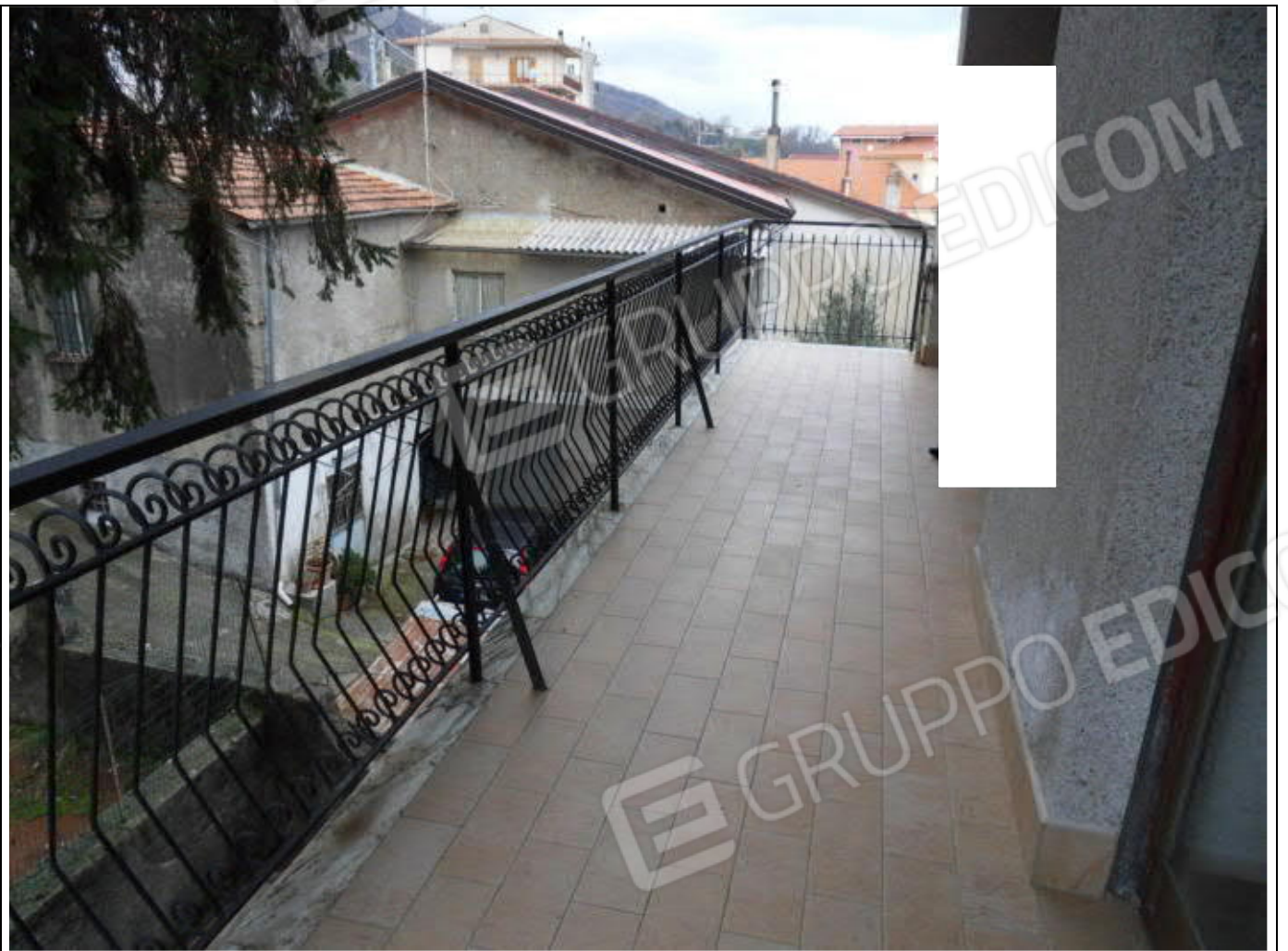
FOTO N. 41: Esterni (balcone) Bene Immobile
