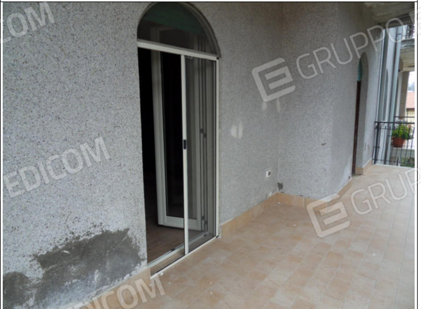
FOTO N. 40: Esterni (balcone) Bene Immobile
