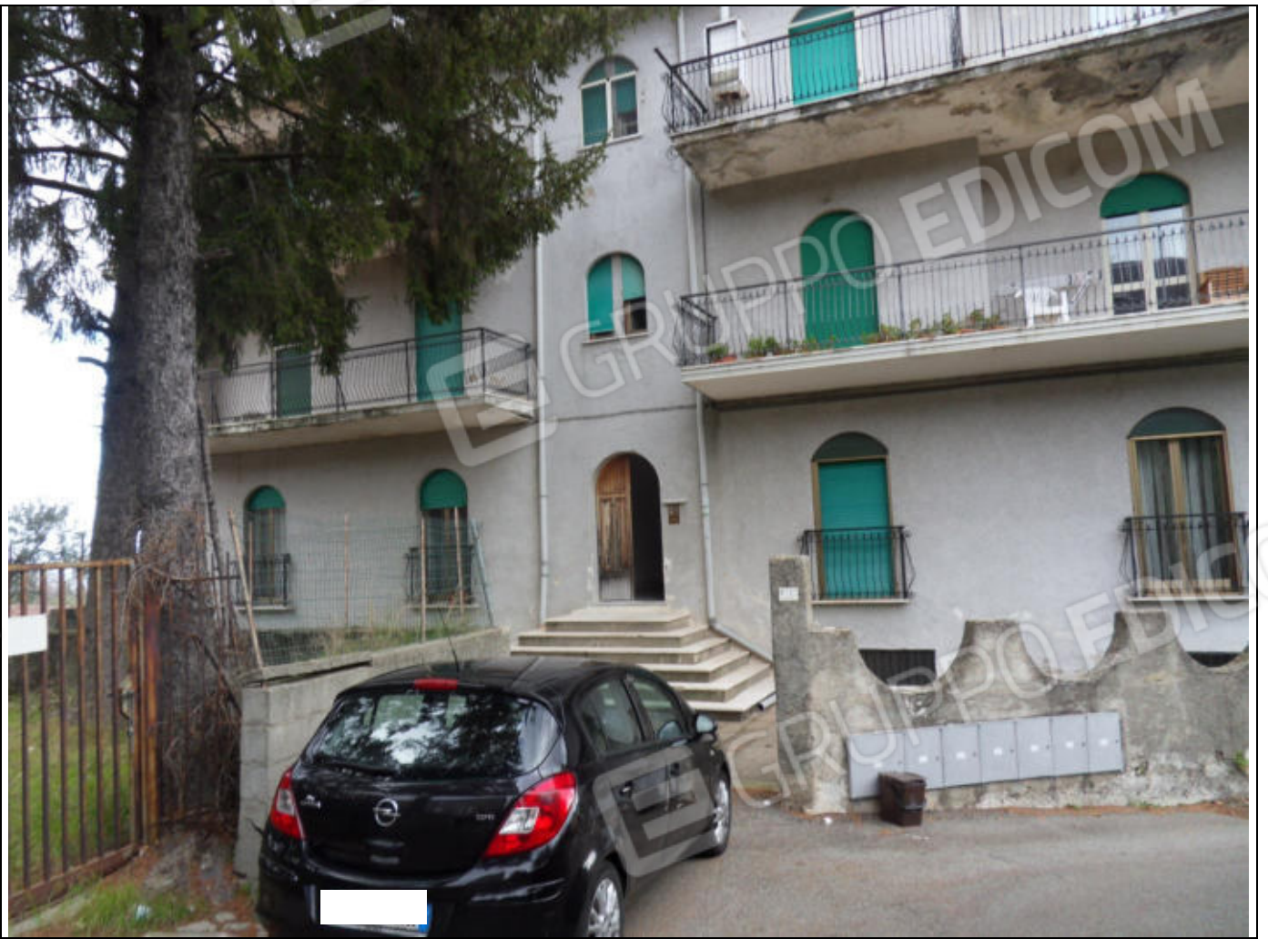
FOTO N. 1: Prospetto OVEST (Ingresso Fabbricato)
