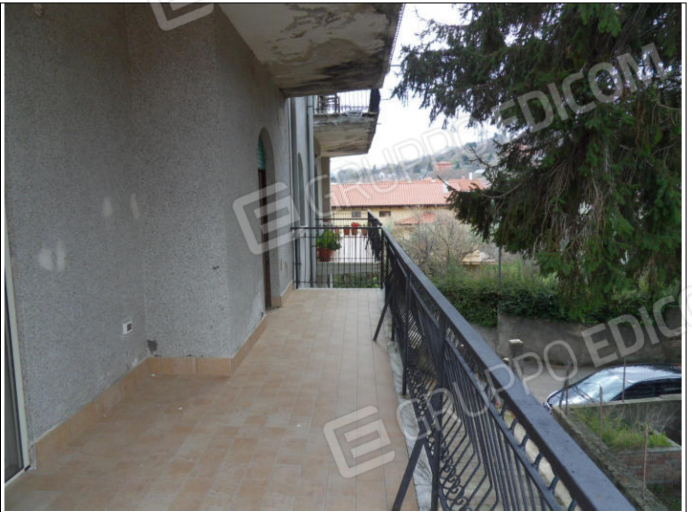
FOTO N. 39: Esterni (balcone) Bene Immobile
