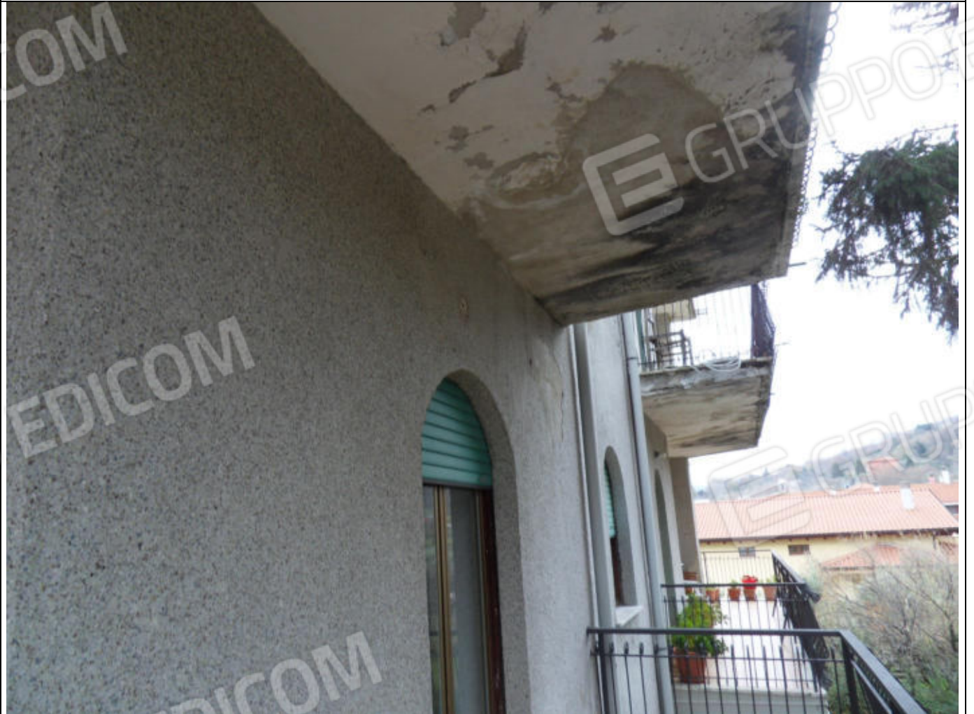
FOTO N. 42: Esterni (balcone) Bene Immobile
