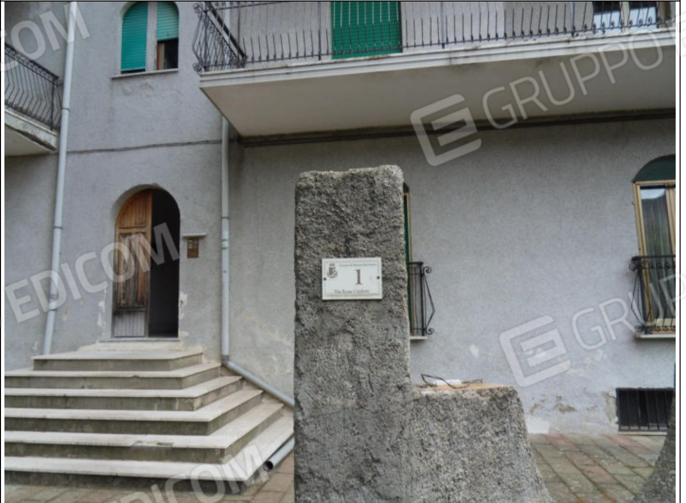
FOTO N. 2: Prospetto OVEST (Ingresso Fabbricato)
