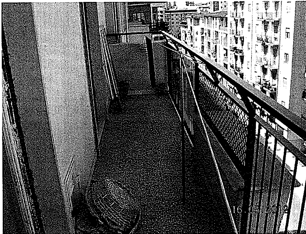
FOTO N. 08 BALCONE CUCINA E RIPOST
