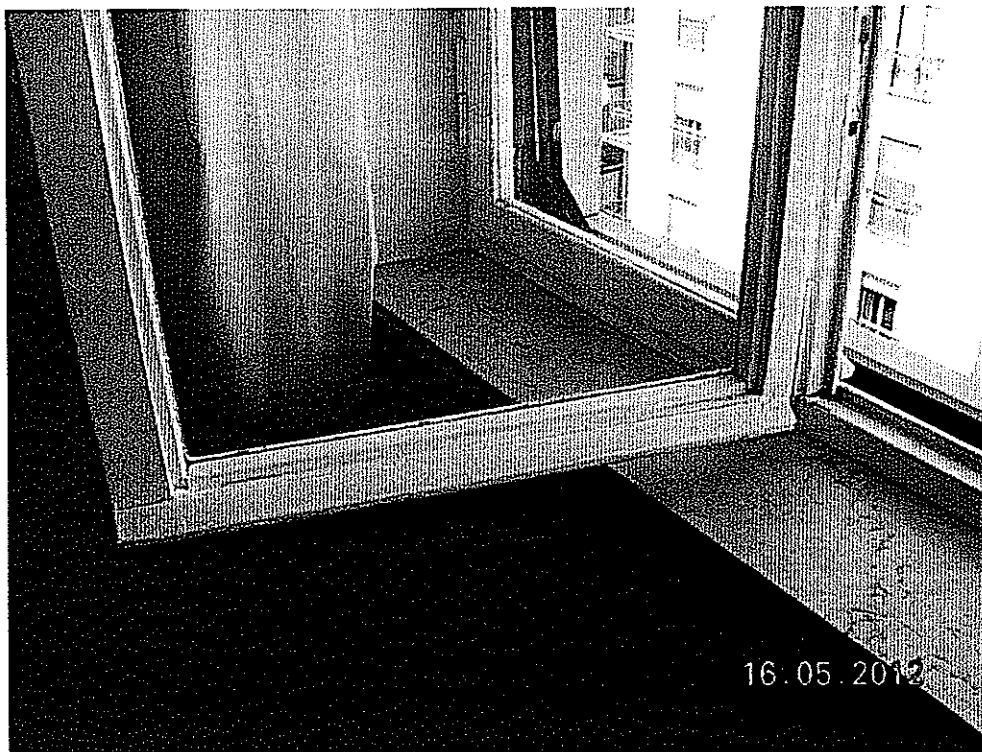
FOTO N. 10 INFISSO ESTERNO IN FERRO
