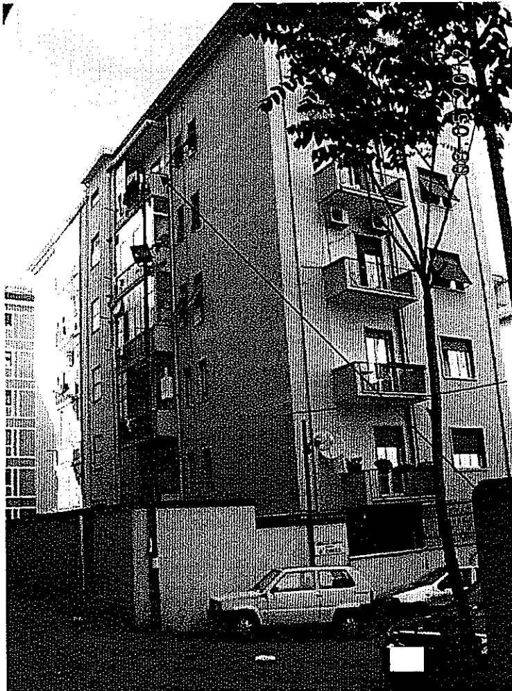
N. 02 VISTA POSTERIORE FABBRICATO IN COSENZA VIA PASQUALE ROSSI 35 (APPARTAMENTO)
