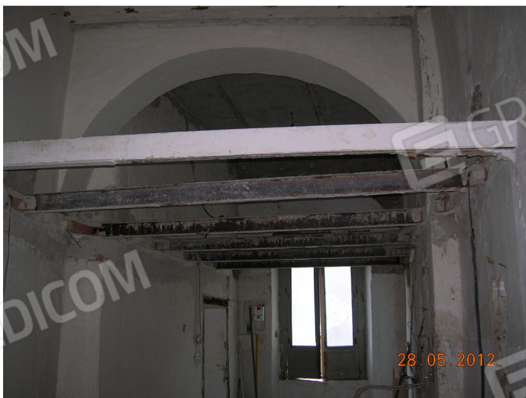
FOTO N. 08 STRUTTURA DEL SOLAIO
