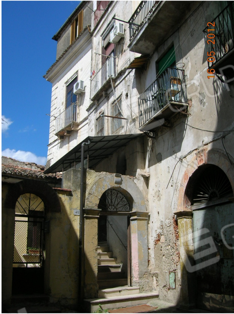
FOTO N. 01 INGRESSO FABBRICATO IN COSENZA CENTRO STORICO S. LUCIA
