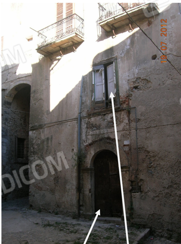
FOTO N. 10 LOCALE A PIANO TERRA E PRIMO VICO IV° SANTA LUCIA ERRONEAMENTE RIPORTATO IN CATASTO ALLA P.LLA 674 SUB 9 NON DI PROPRIETA' DEL DEBITORE ESECUTATO
